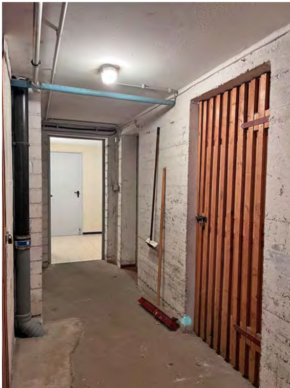
Kellerflur links mit Abstellkellern
