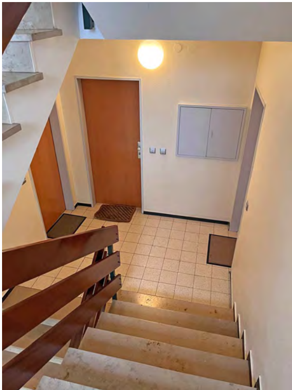
Treppenhaus EG / 1. OG
