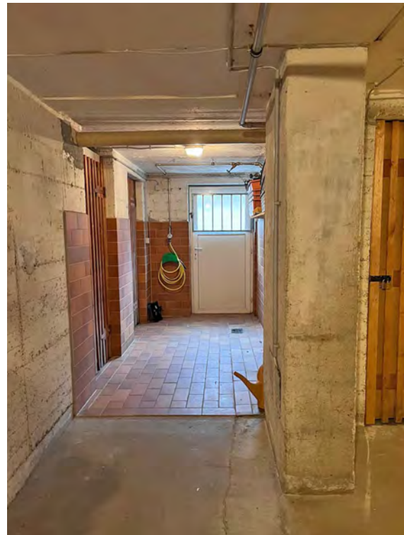
Ausgang zur Kelleraußentreppe
