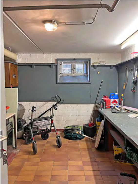
Hausmeisterraum hinten rechts
