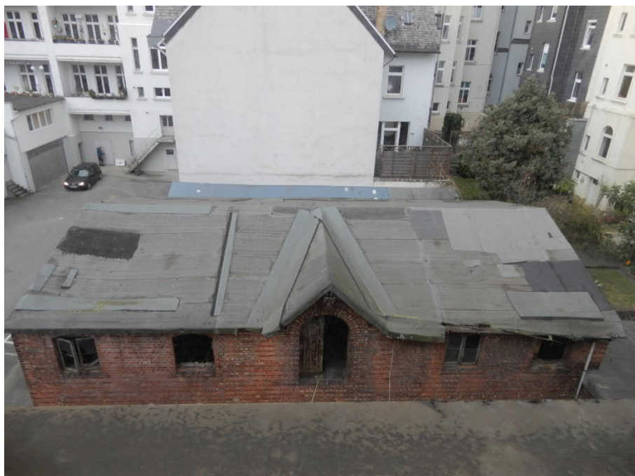
Hinterhaus Gesamtansicht Dach
