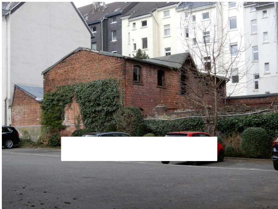
Hinterhaus Seitenansicht vom Nachbargrundstück aus
