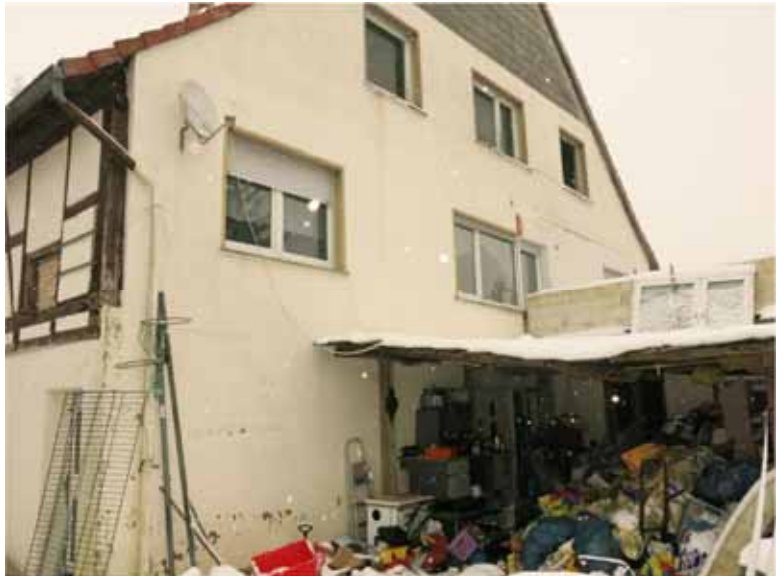
Feuchte-Schäden am Putz und Fachwerk, starke Vermüllung
