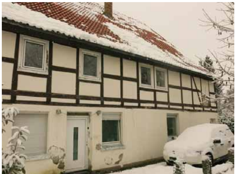
Westseite (Haupteingang); Feuchte-Schäden am Putz und Fachwerk
