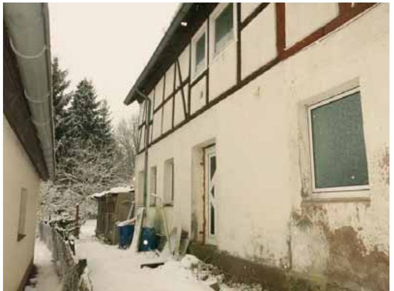
Westseite (Haupteingang); Feuchte-Schäden am Putz und Fachwerk
