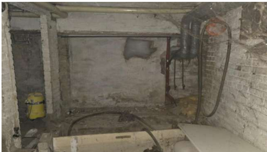
Wanddurchbruch zwischen 2 Kellerräumen zu SE 3.
