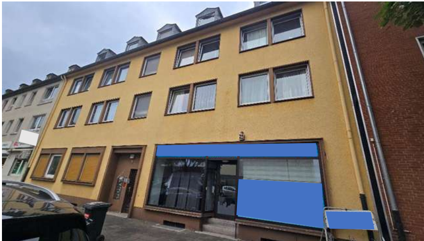
Straßenseitiger Blick auf das Wohn- und Geschäftshaus.
