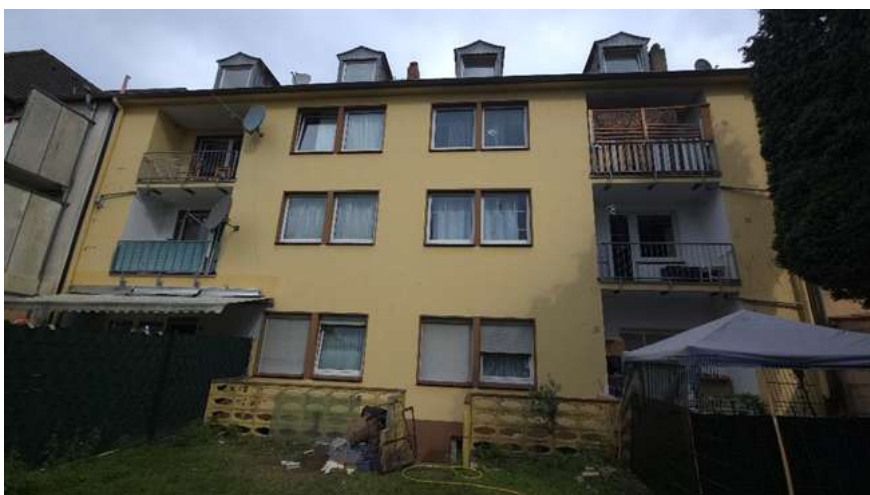
Gebäuderückseite mit Vermüllung im hinteren Grundstücksbereich.
