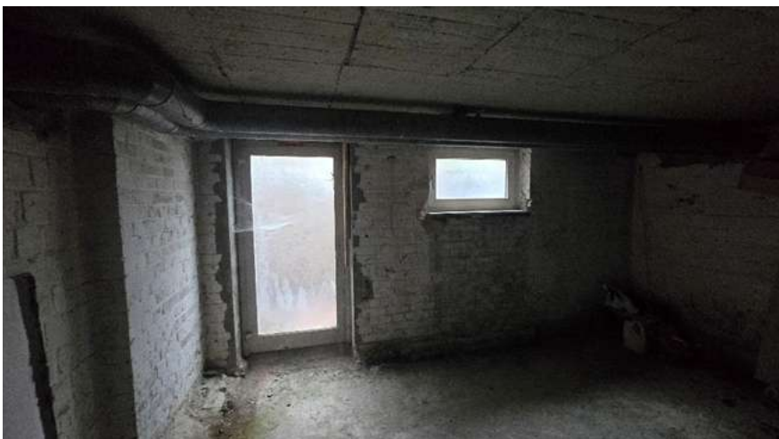
Kellerraum zu SE 3 mit Nebeneingangstür zum Hof.
