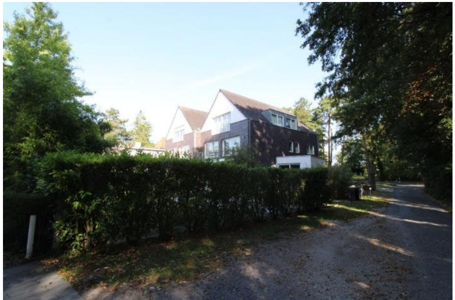
Blick auf die Rückseite des Gebäudes
