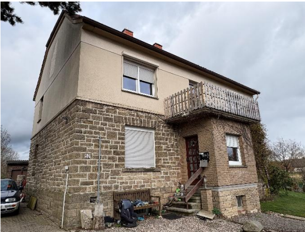
Blick von West
