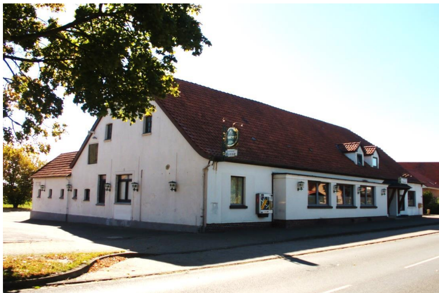
Ansicht von Norden- Straßenfront
