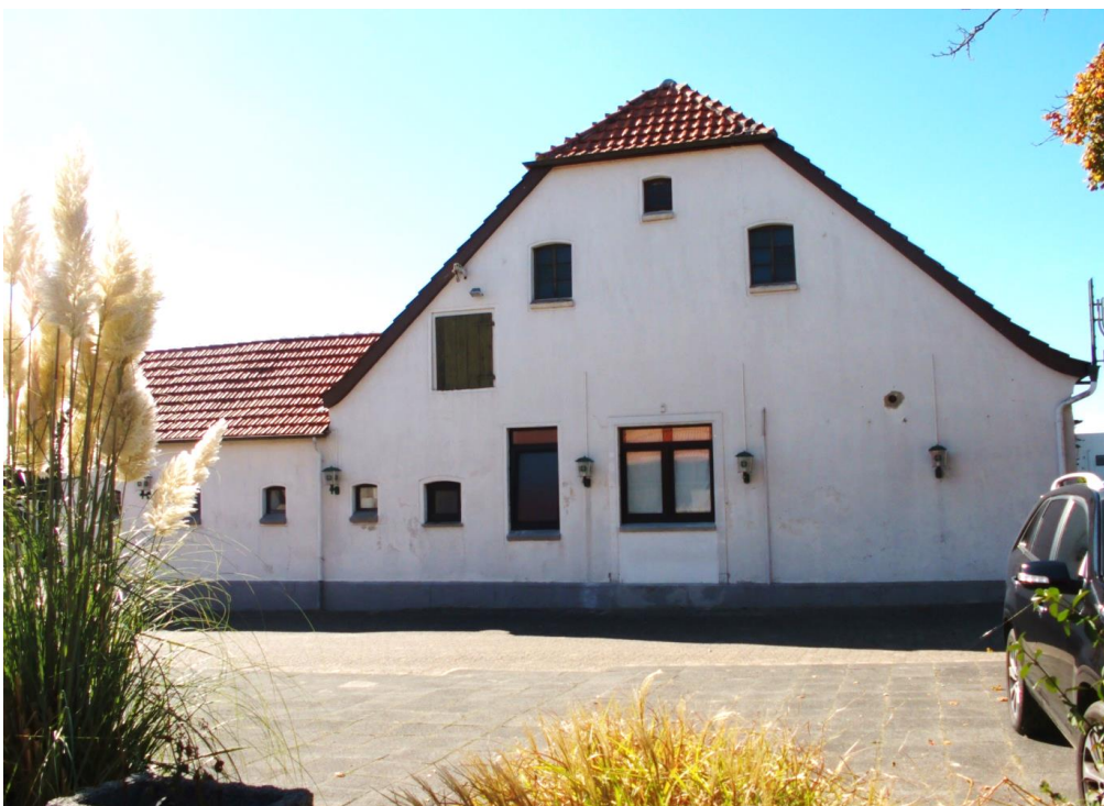
Bild 2 Ansicht Hauptgebäude von Norden
