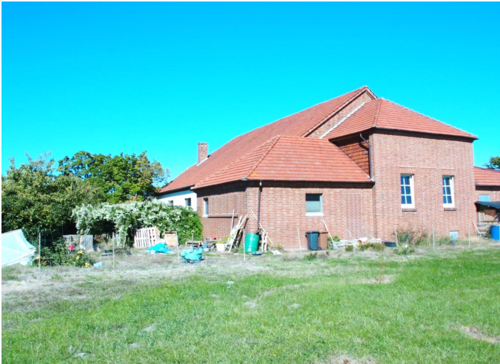
Bild 3 Ansicht Saalanbau von Südosten
