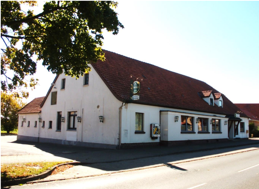
Bild 1 Ansicht Hauptgebäude von Nordwesten
