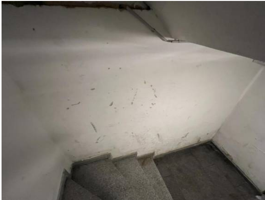
Treppenabgang zum Kellergeschoss
