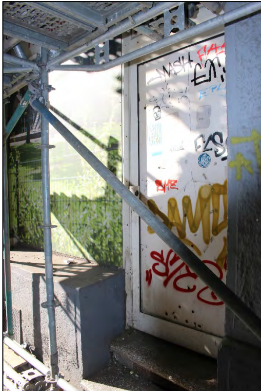
Foto Nr. 9: Straßenfassade / Gewerbeeinheit links
