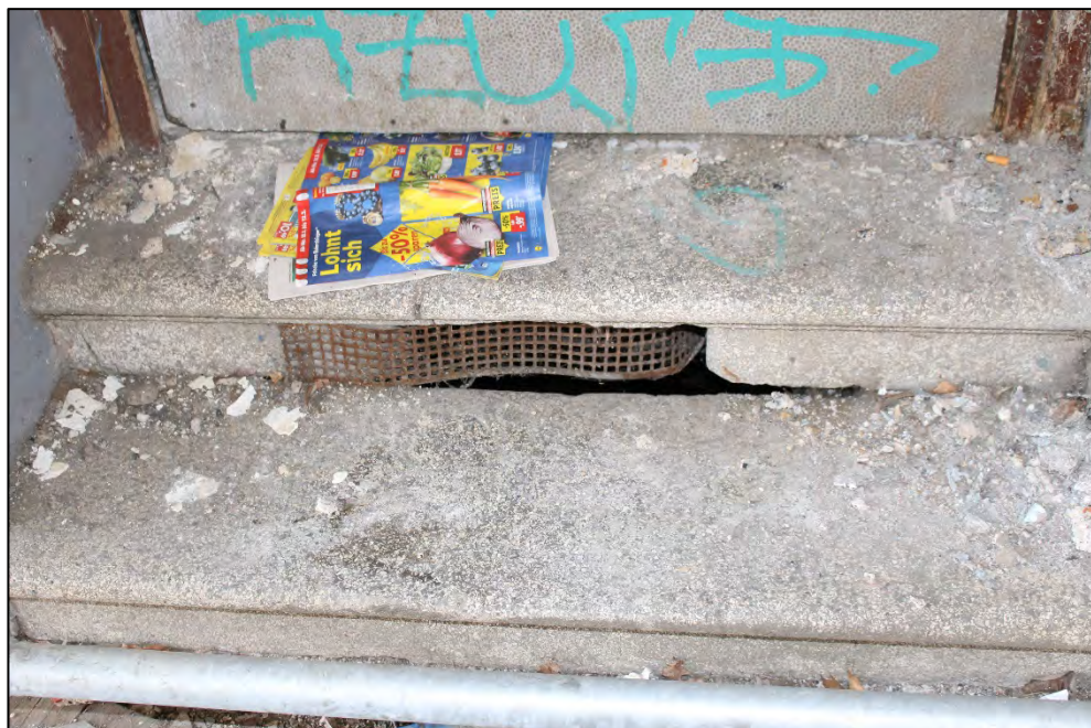
Foto Nr. 8: Straßenfassade / Eingangsstufen
