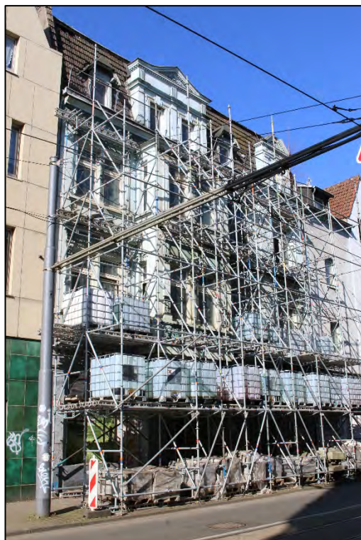
Foto Nr. 4: Straßenfassade
