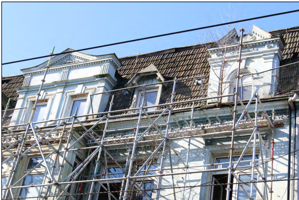
Foto Nr. 2: Straßenfassade / Dachfläche / Gauben
