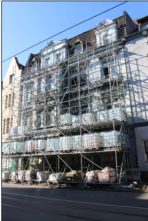
Foto Nr. 1: Straßenfassade
