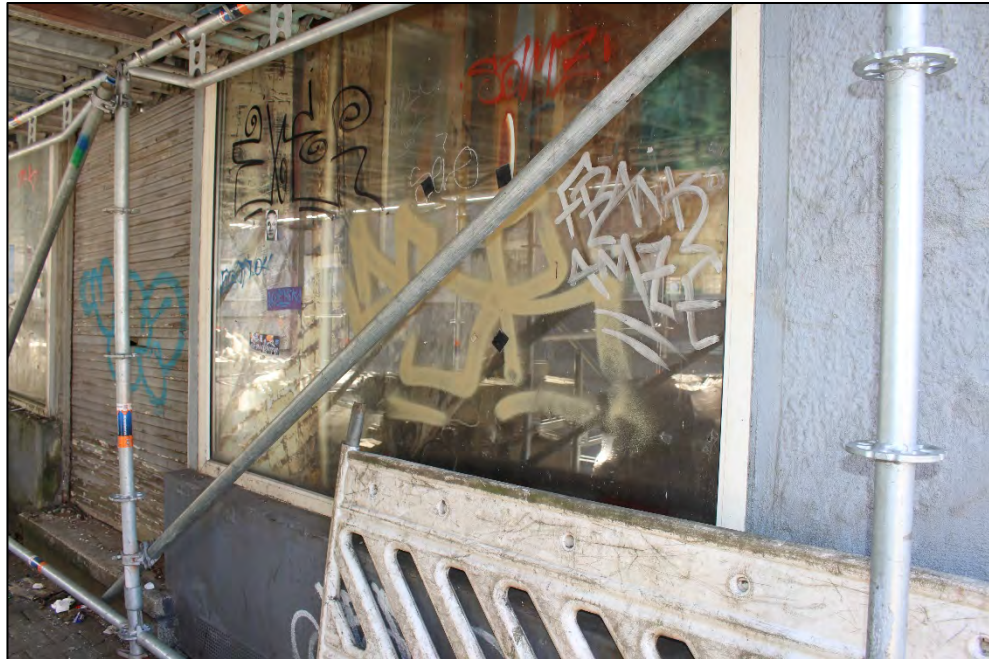
Foto Nr. 5: Straßenfassade / Gewerbeeinheit EG rechts
