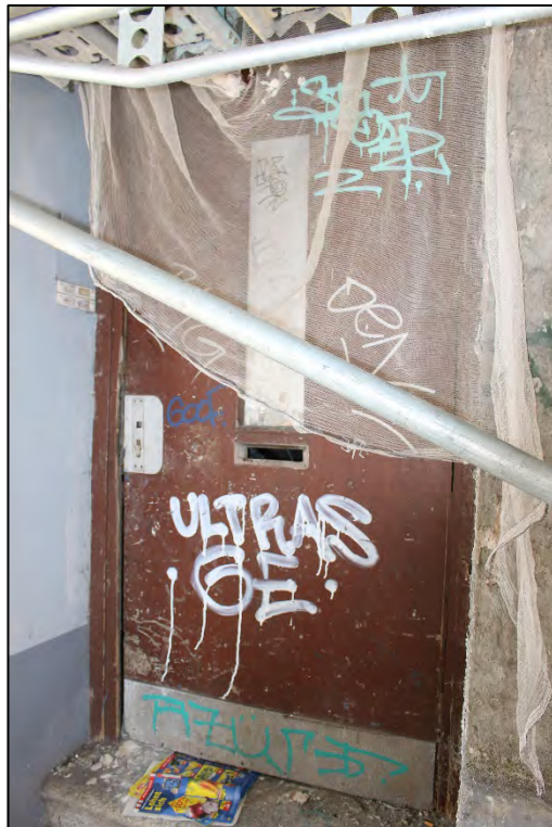
Foto Nr. 7: Straßenfassade / Hauseingang
