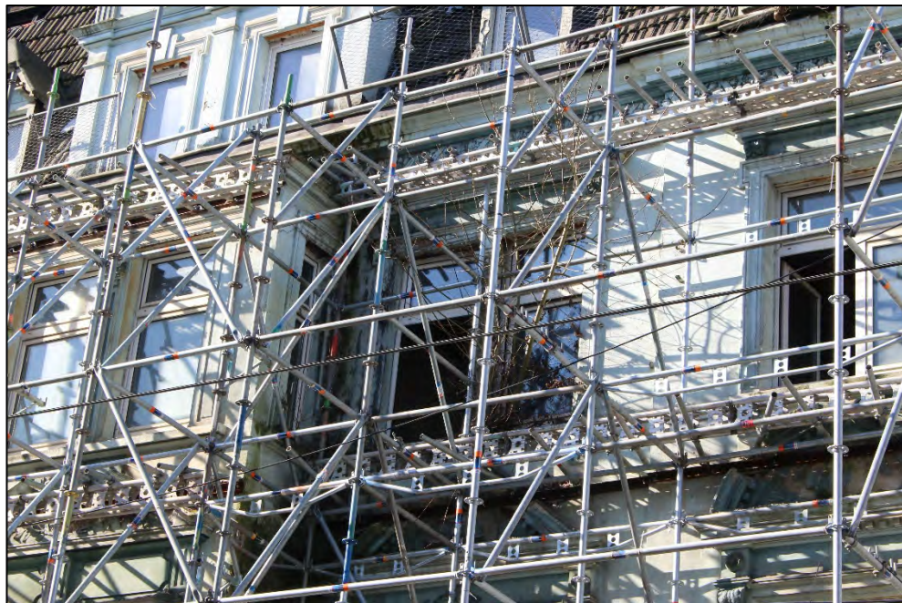
Foto Nr. 3: Straßenfassade / Bewuchs
