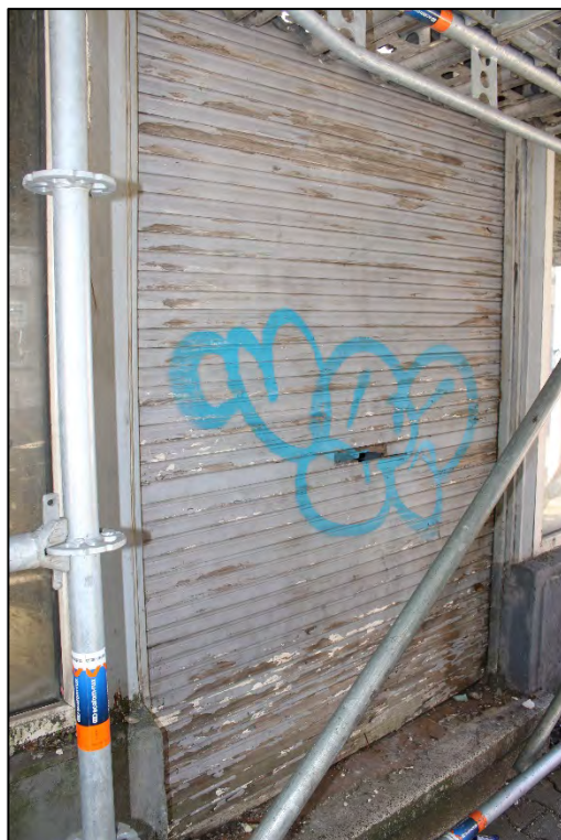
Foto Nr. 6: Straßenfassade / Gewerbeeinheit EG rechts
