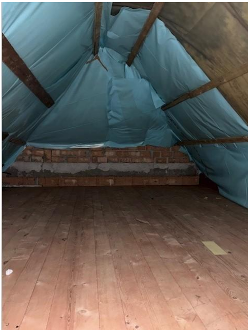
Bild 19: Spitzboden gedämmte Dachflächen
