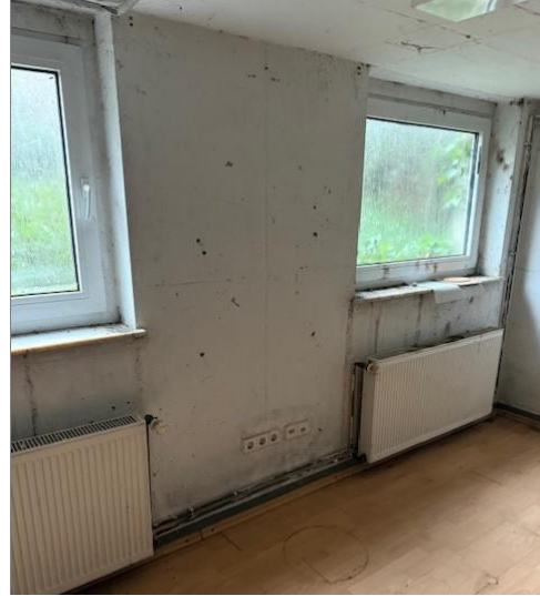
Bild 10: ausgebaut Raum KG
