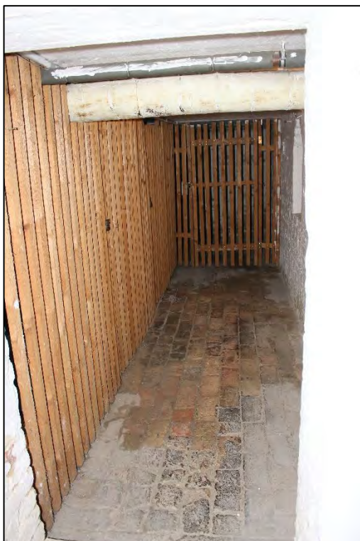
Foto Nr. 18: Kellergeschoss, Abstellräume
