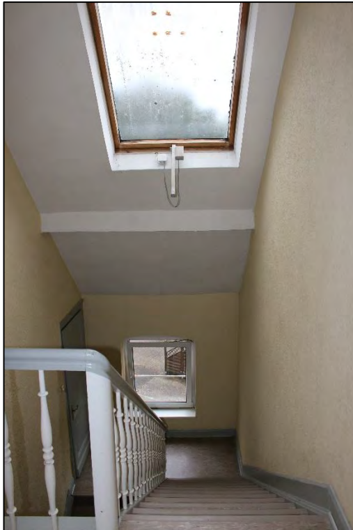
Foto Nr. 27: Gemeinschaftstreppehaus, Dachgeschoss
