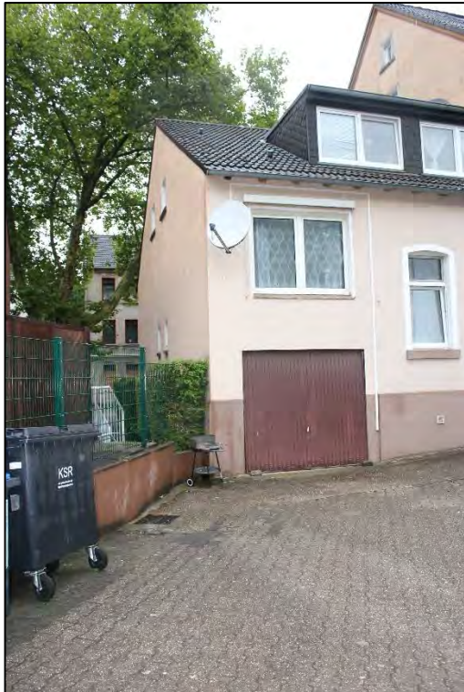
Foto Nr. 5: Seiten- und Hoffassade
