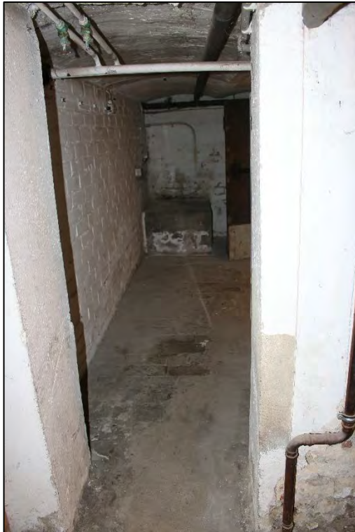
Foto Nr. 23: Kellergeschoss, Flur
