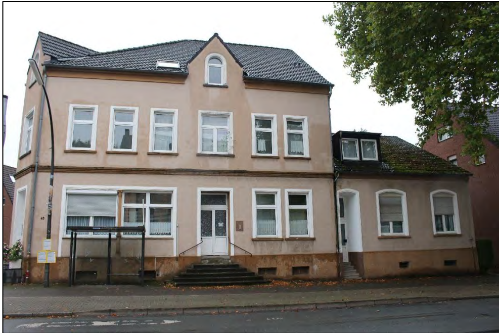
Foto Nr. 1: Straßenfassade Ortlohstraße
