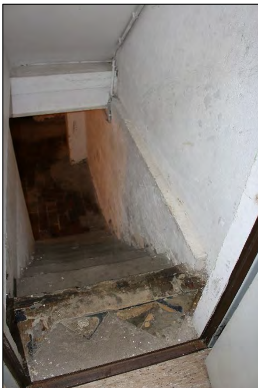
Foto Nr. 10: Treppe zum Kellergeschoss
