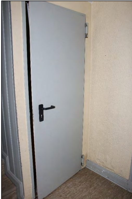
Foto Nr. 9: Gemeinschaftstreppehaus, Erdgeschoss, Tür zum Kellerabgang
