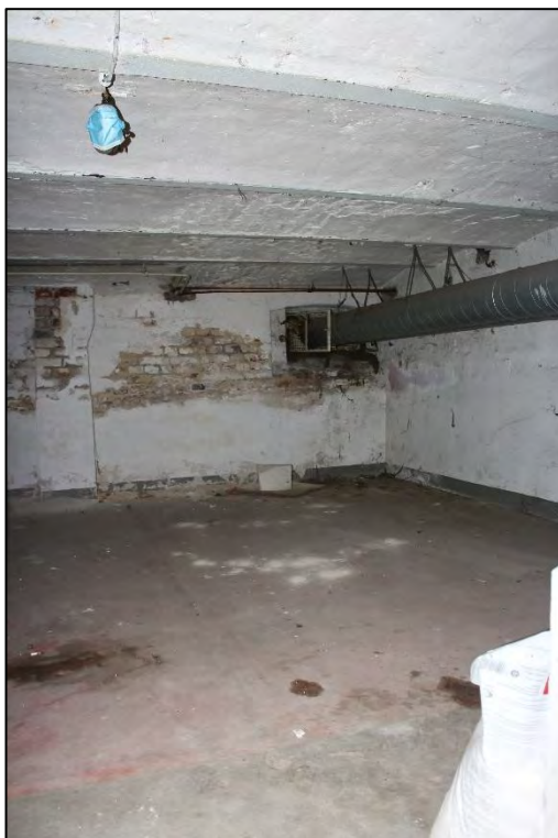
Foto Nr. 16: Kellergeschoss, Kellerraum
