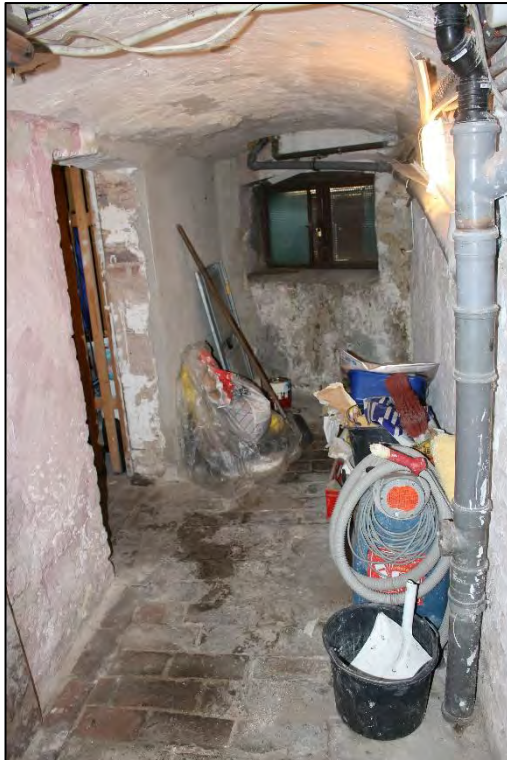
Foto Nr. 25: Kellergeschoss, Flur
