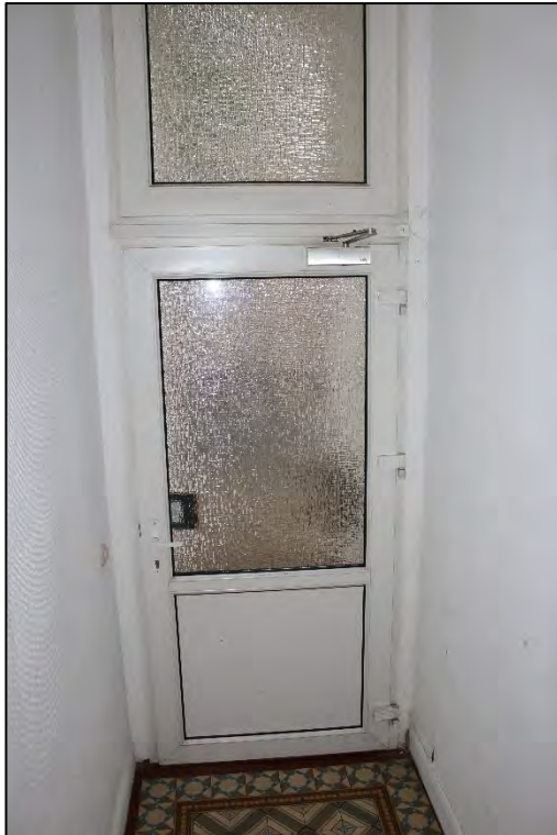
Foto Nr. 29: Gemeinschaftstreppe, Hauseingang, Eingang Ortlohstraße
