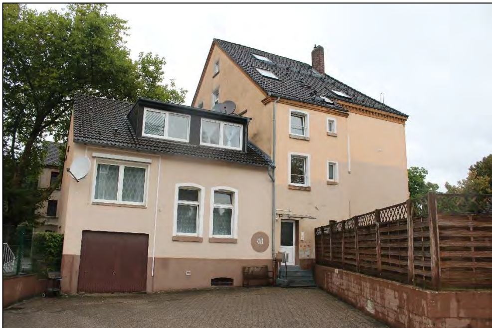
Foto Nr. 4: Hoffassade
