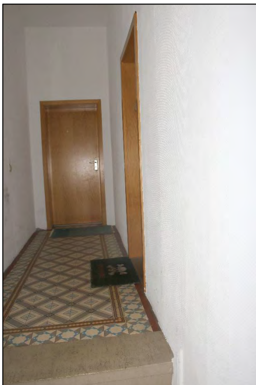
Foto Nr. 28: Gemeinschaftstreppehaus, Eingang Ortlohstraße
