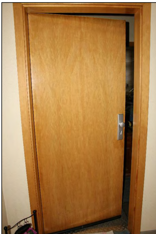
Foto Nr. 30: Gemeinschaftstreppe, Erdgeschoss, Eingang ETW Nr. 2
