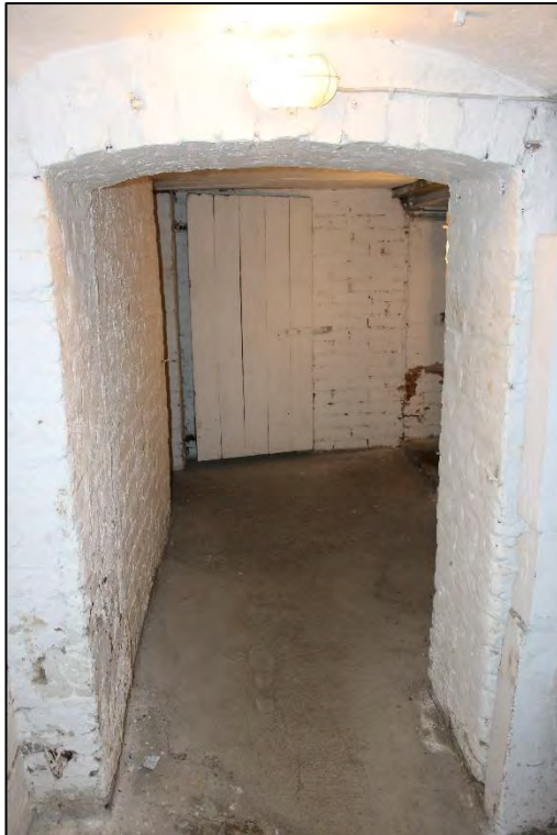
Foto Nr. 11: Kellergeschoss, Flur
