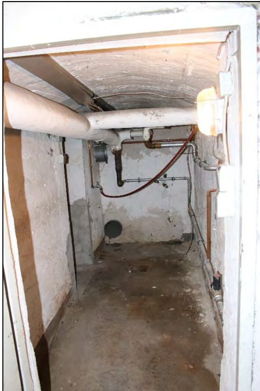
Foto Nr. 15: Kellergeschoss, Kellerraum
