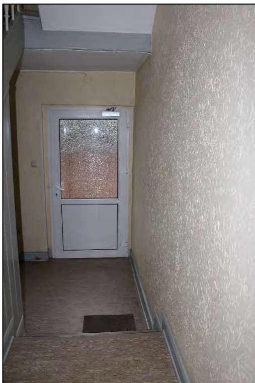
Foto Nr. 8: Gemeinschaftstreppehaus, Erdgeschoss, Hauseingang
