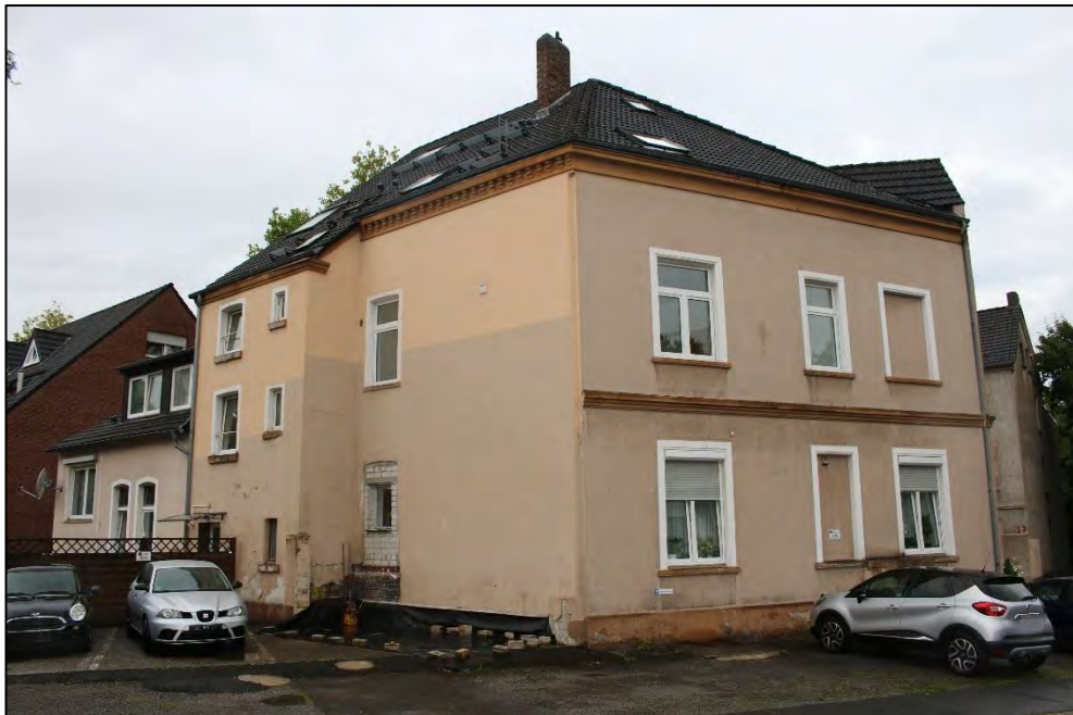
Foto Nr. 2: Seitenfassade / Hoffassade Reginastraße
