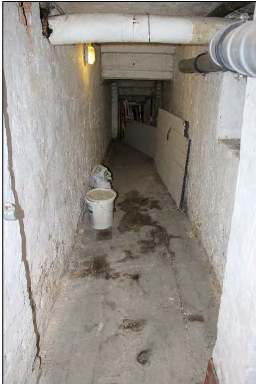
Foto Nr. 17: Kellergeschoss, Flur
