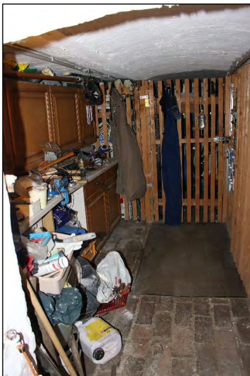
Foto Nr. 24: Kellergeschoss, Abstellräume
