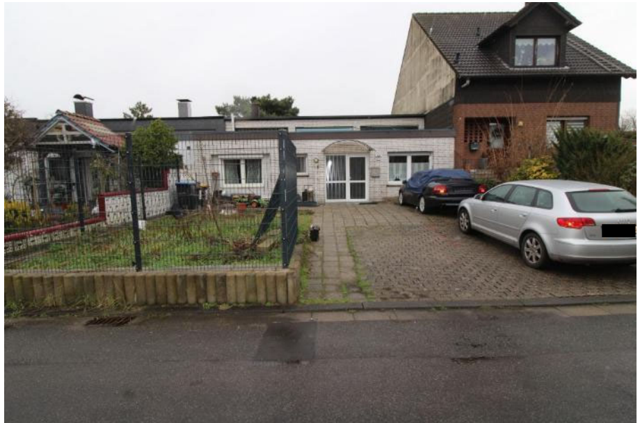
Sicht von der Straße aus auf die Vorderfas- sade des Objekts
