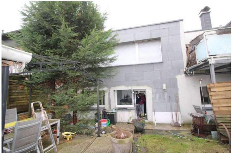
Sicht vom Garten aus auf die Rückfassade des Objekts
