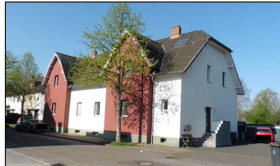
Abb: straßenseitige Ansicht
