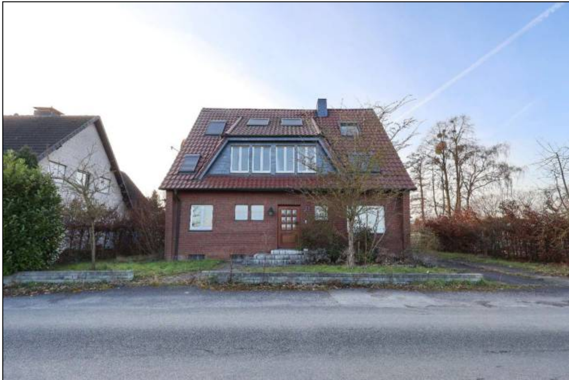
Abbildung 8 Straßenansicht der baulichen Anlage Einfamilienhaus Foto Nr. 3, fotografiert am 22.01.2026
