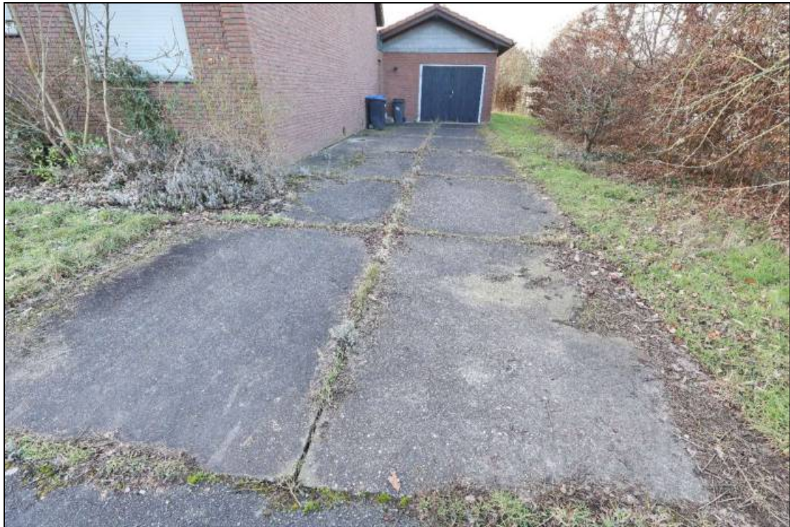
Abbildung 22 Zufahrt zur Garage Foto Nr. 8, fotografiert am 22.01.2026
