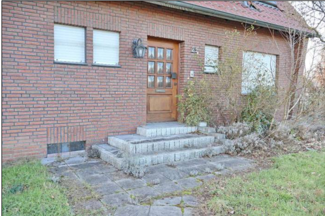
Abbildung 23 Hauseingangsbereich Foto Nr. 9, fotografiert am 22.01.2026
