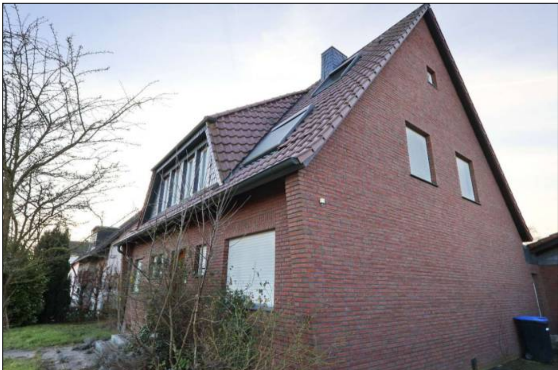
Abbildung 9 Straßen- und Seitenansicht der baulichen Anlage Einfamilienhaus Foto Nr. 4, fotografiert am 22.01.2026
