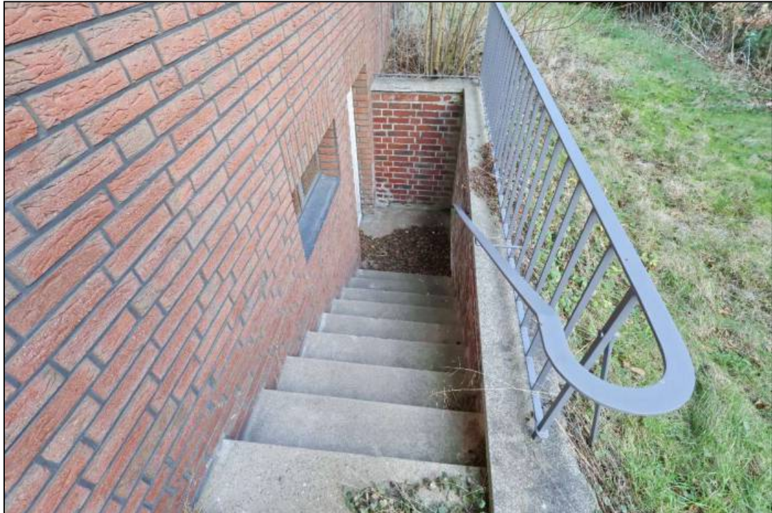
Abbildung 25 Kelleraußentreppe Foto Nr. 11, fotografiert am 22.01.2026
