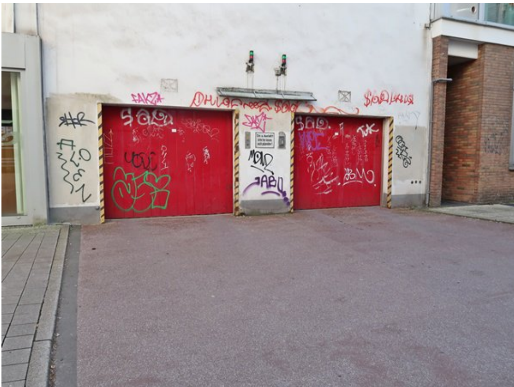
Kfz-Aufzüge mit Zufahrt von der Straße Mäuerchen
