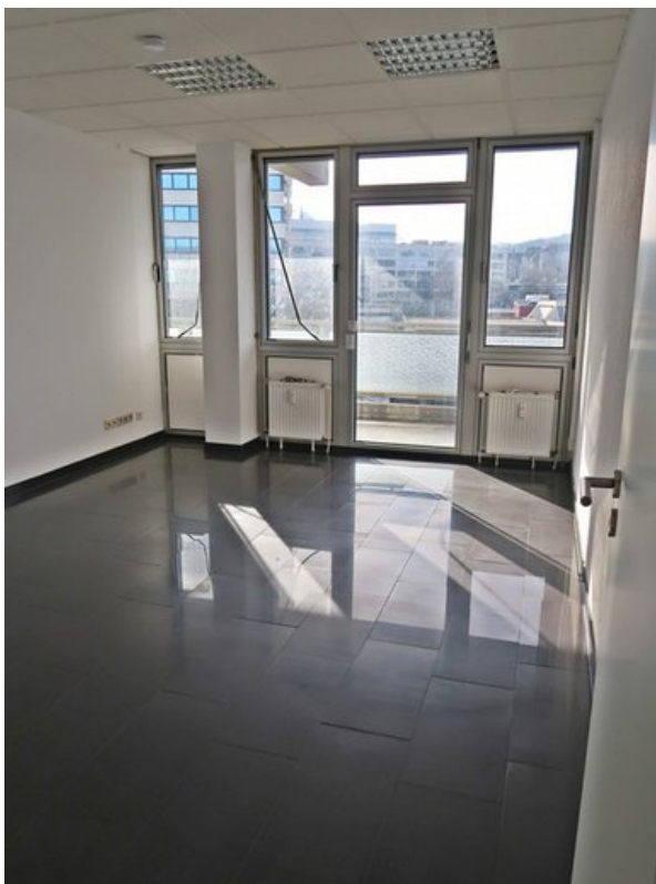
Küche, die erforderlichen Kücheninstallationen sind nicht vorhanden
