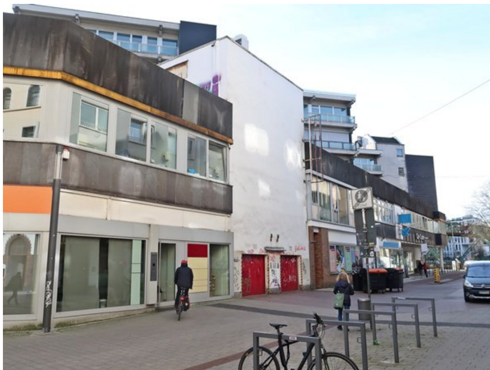
Ansicht von der Straße Mauerchen
