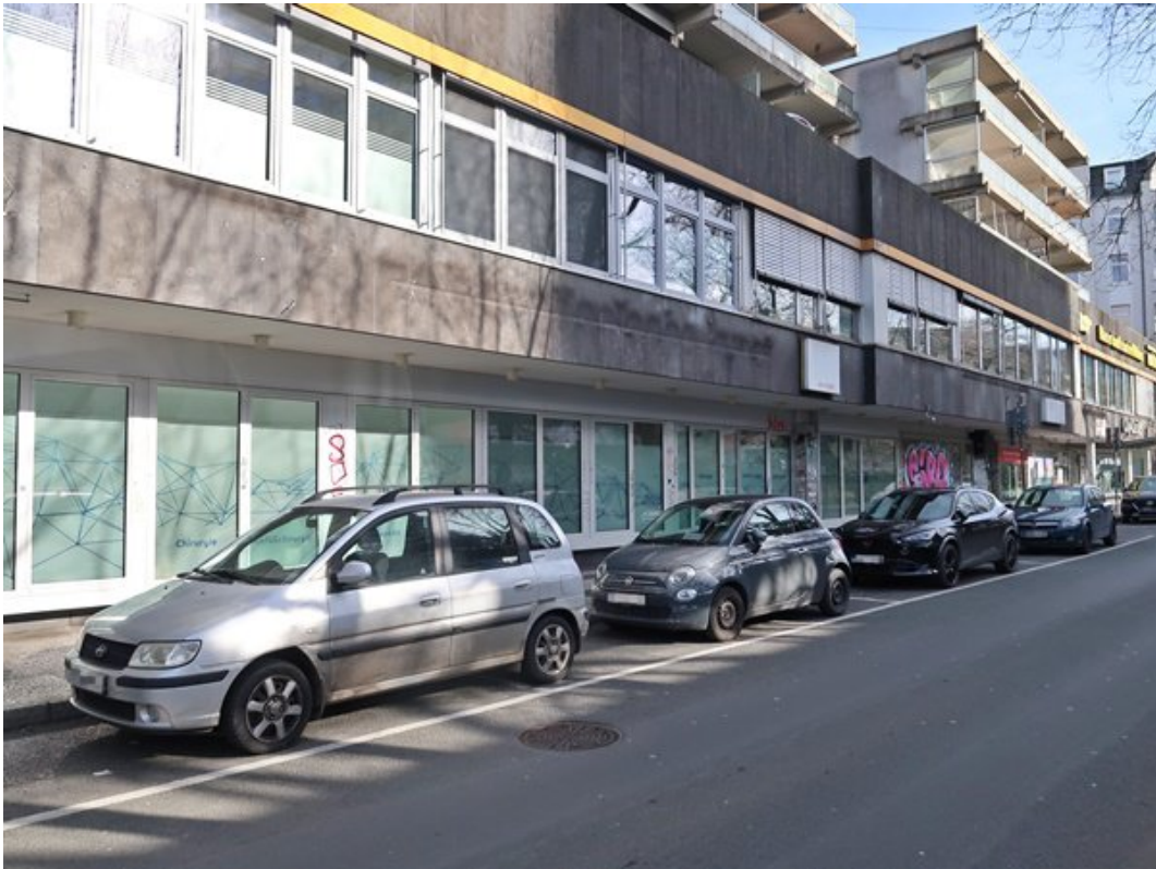
Teilansicht von der Straße Schöoßbleiche
