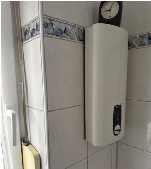
Bild 11: Durchlauferhitzer Bad
