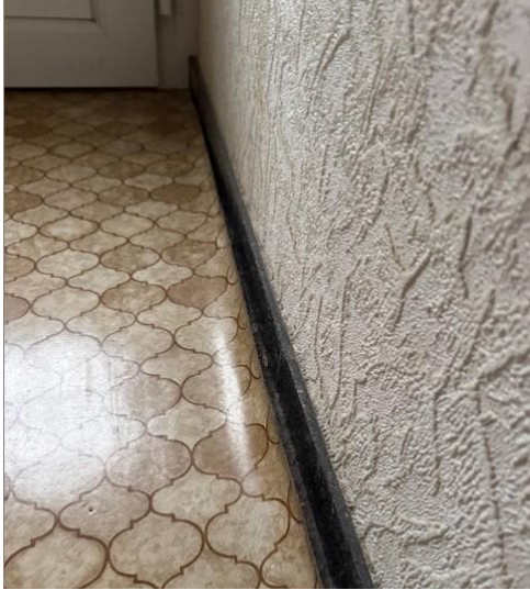
Bild 13: loser Bodenbelag
