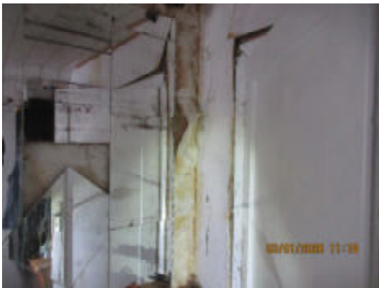
Detail Feuchteeinwirkung
