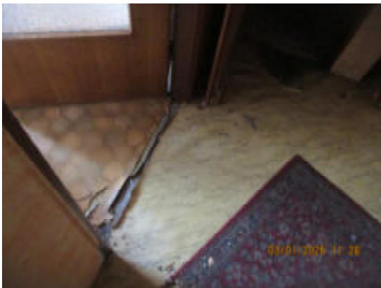
Schadhafter Fußbodenbelage
