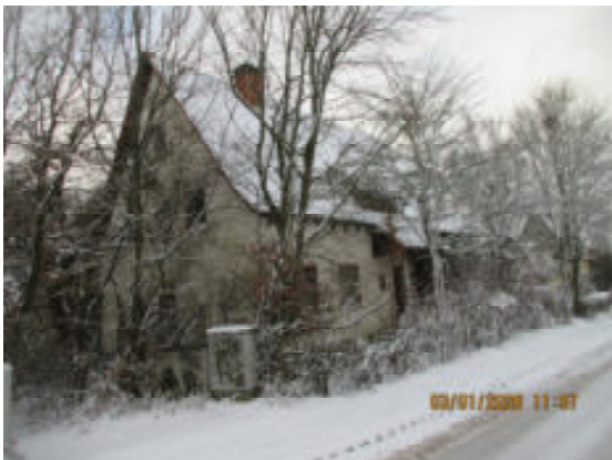
Ansicht von Südosten
