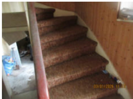
Treppe vom EG zum DG
