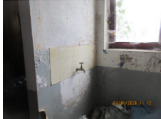
Vorraum zum Treppenhaus mit Wasseranschluss
