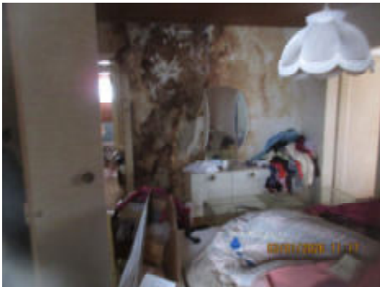
Schlafzimmerwand zum Flur / starke Feuchtespuren / im Bereich des Schornsteins
