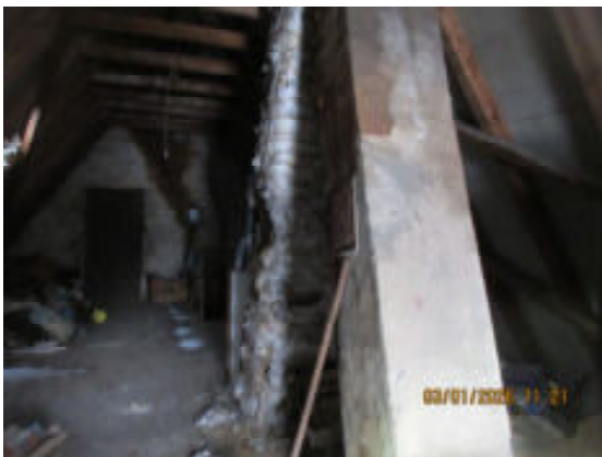
Abgängige Schornsteindämmung
