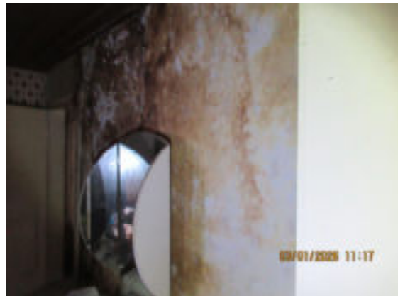
Schlafzimmerwand zum Flur / starke Feuchtespuren / im Bereich des Schornsteins
