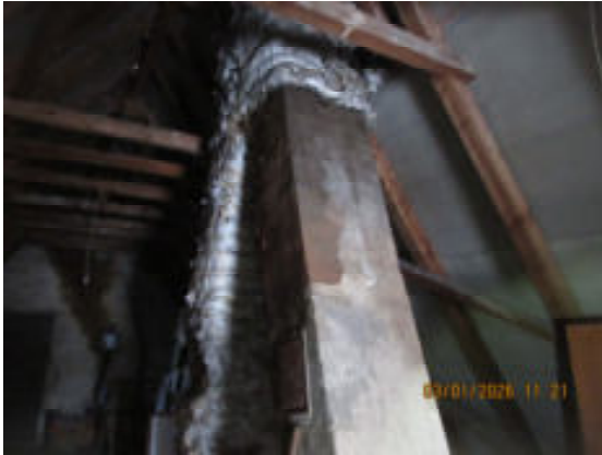
Schornstein im Firstbereich
