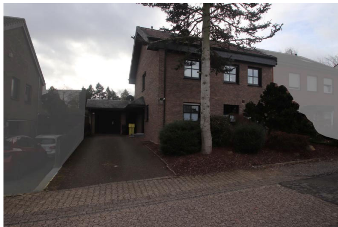
Straßenansicht am Tage der Ortsbegehung am 19. Juni 2023
