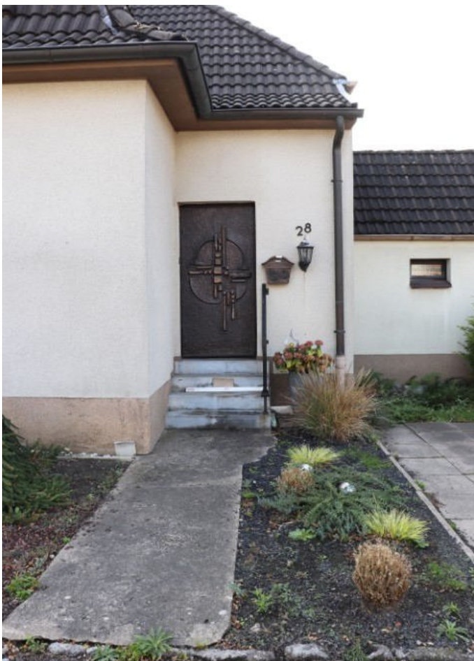
Bild 6 Kriemhildstraße 28 -Hauseingang rechter Gebäudeteil-
