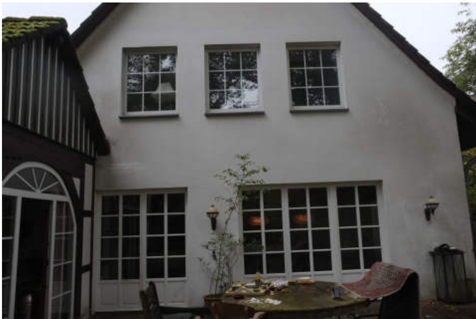
Bild 8: Ansicht von der Gartenseite des Einfamilienhauses
