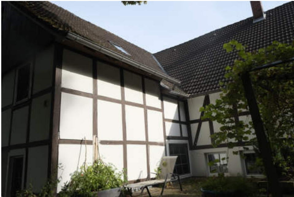
Bild 5: Wohntrakt mit angebautem Scheunengebäude
