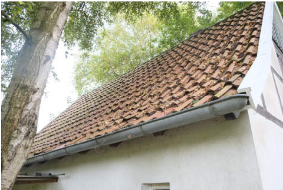
Bild10: Blick auf die Dachfläche des Gartenhauses
