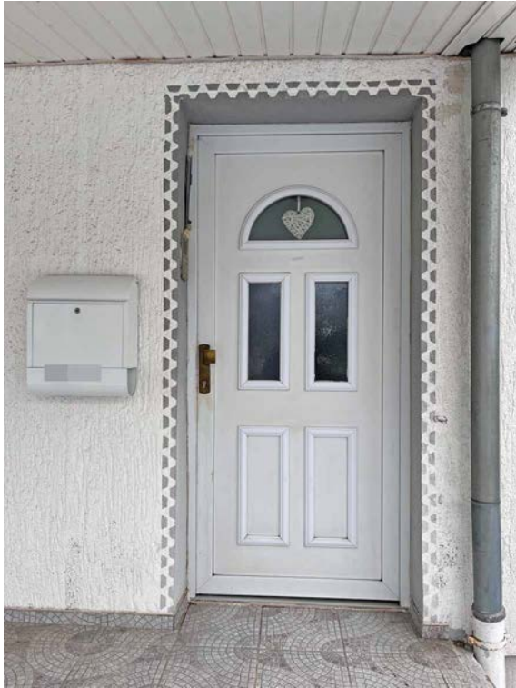
Eingang Wohnung Obergeschoss
