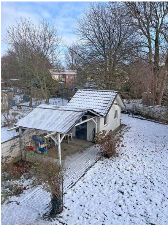
Gartenhaus mit Terrassenüberdachung von oben
