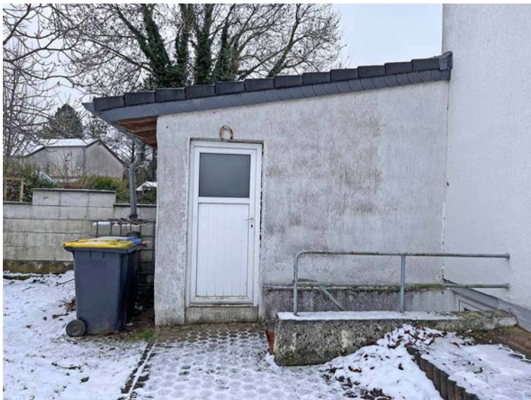
Ansicht Garage hinten
