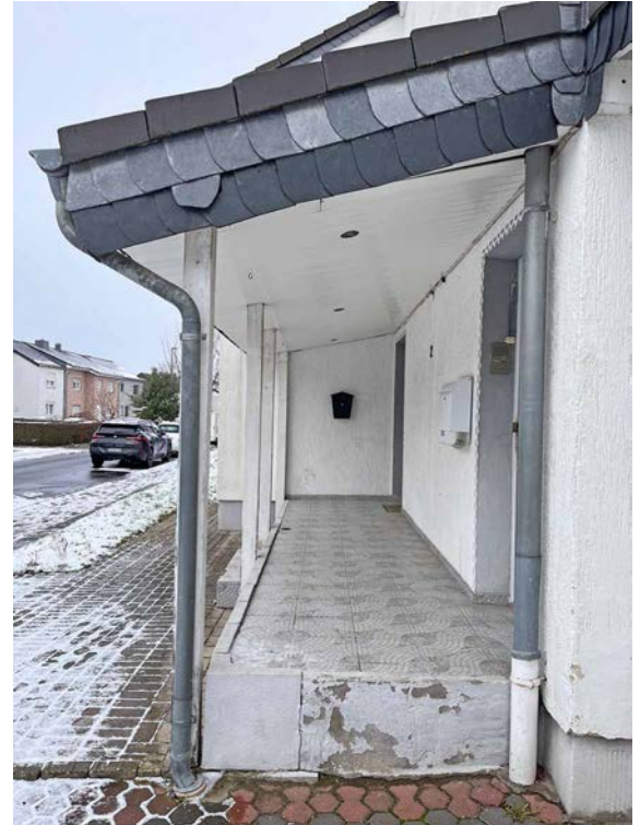
Vordach mit Zugang zu den Wohnungen
