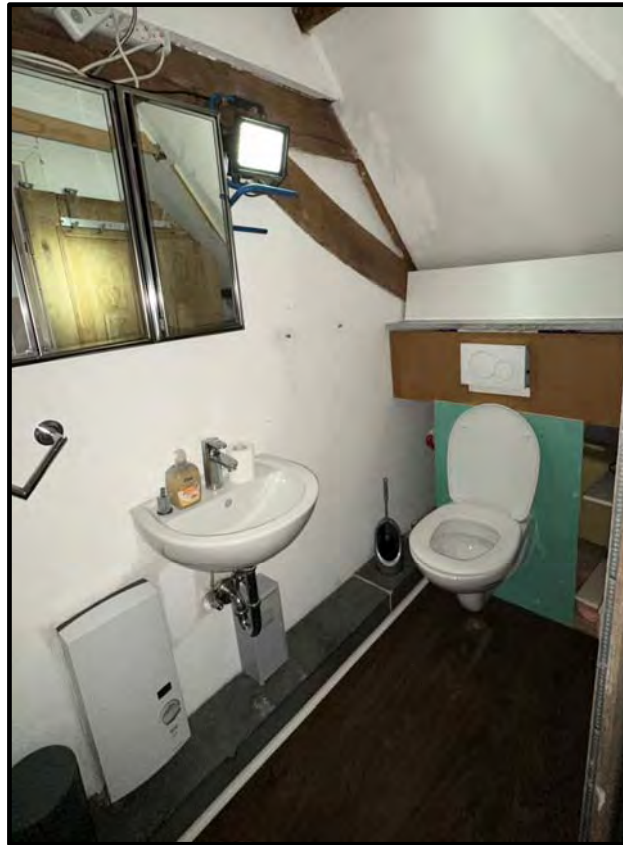
WC im Dachgeschoss
