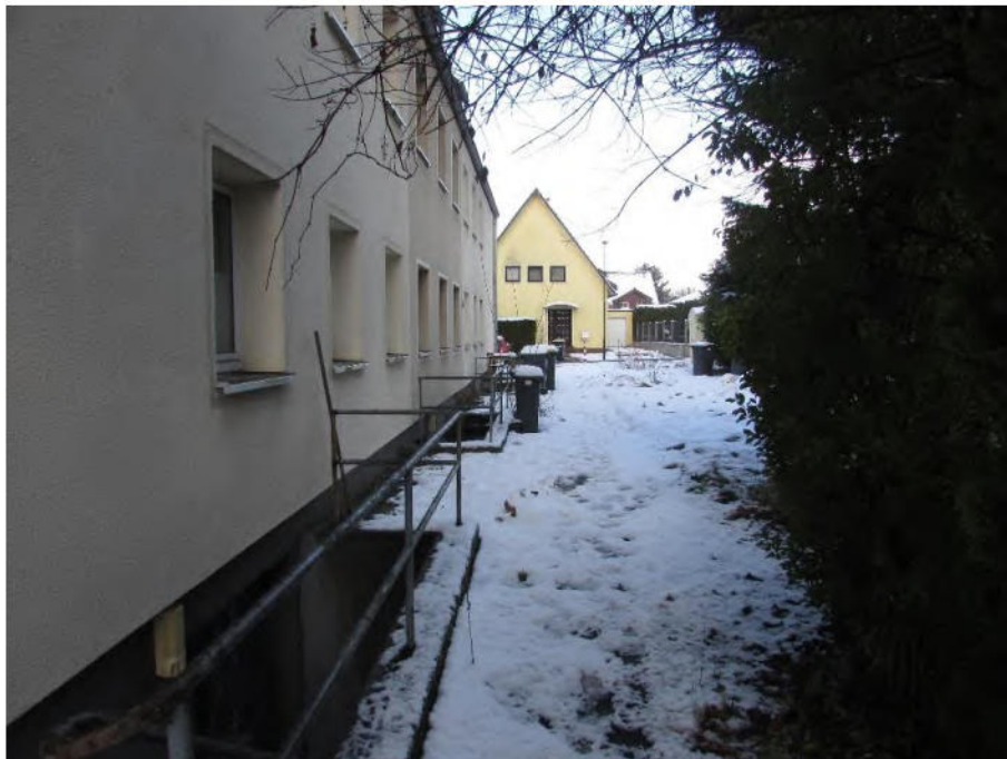
Foto 4: Wohnhaus, rückwärtige Kellerzugänge
