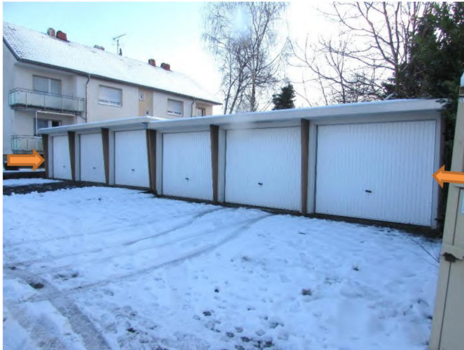
Foto 11: Flurstück 337, PKW-Reihengaragen, Straßenansicht
