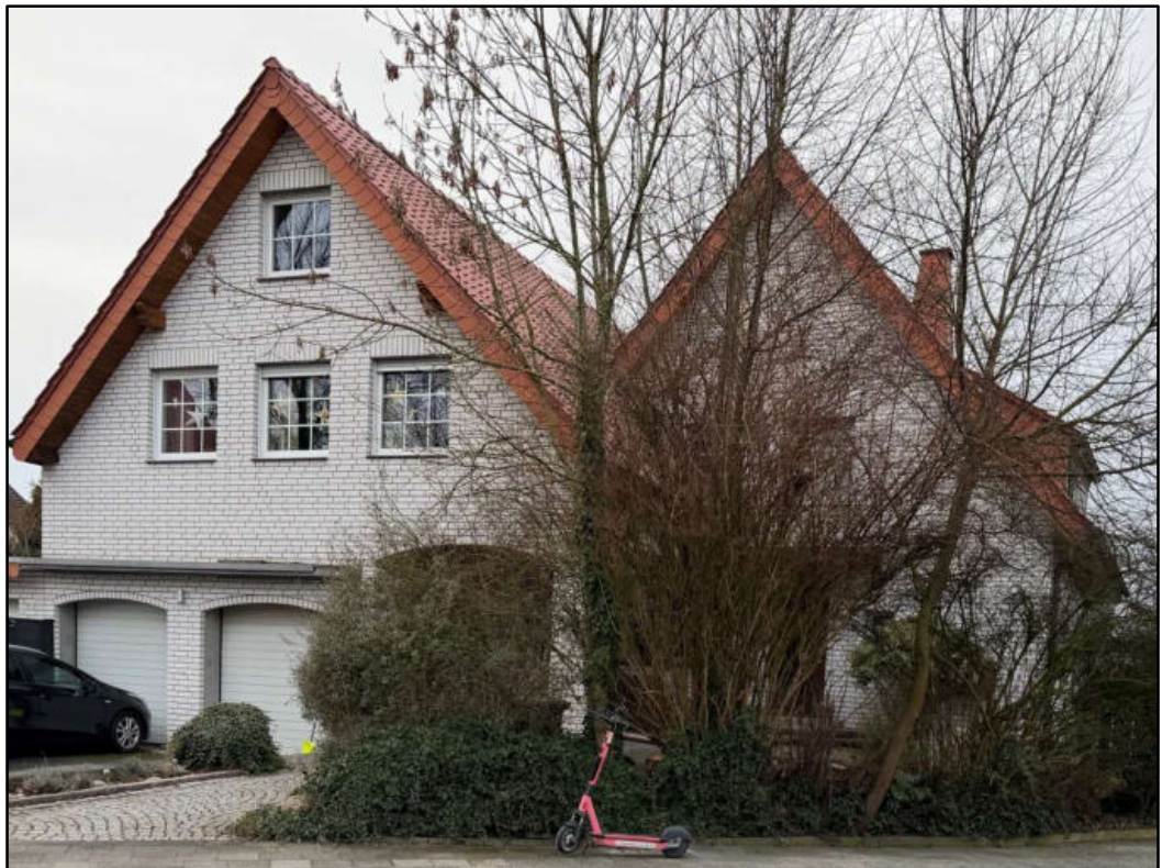
Elser Bruch 39, links Anbau/Aufstockung 1999, rechts hinterer, älterer Gebäudeteil
