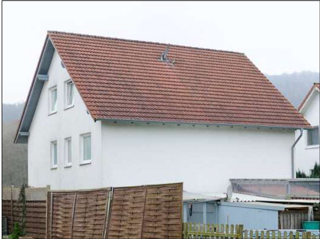
Haus Nr. 92 | 90: Süd-West-Ansicht
