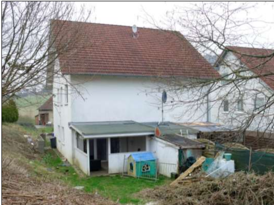
Haus Nr. 96 | 94: Süd-West-Ansicht
