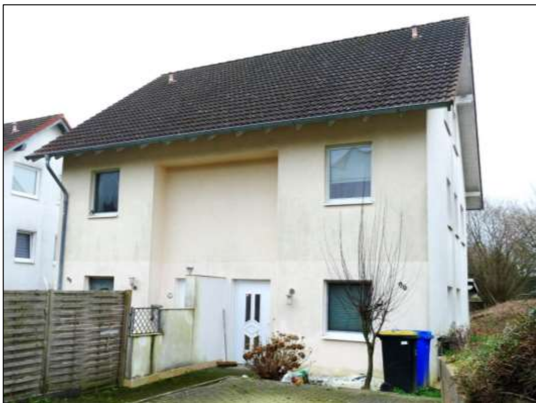
Haus Nr. 94 | 96: Nord-Ansicht
