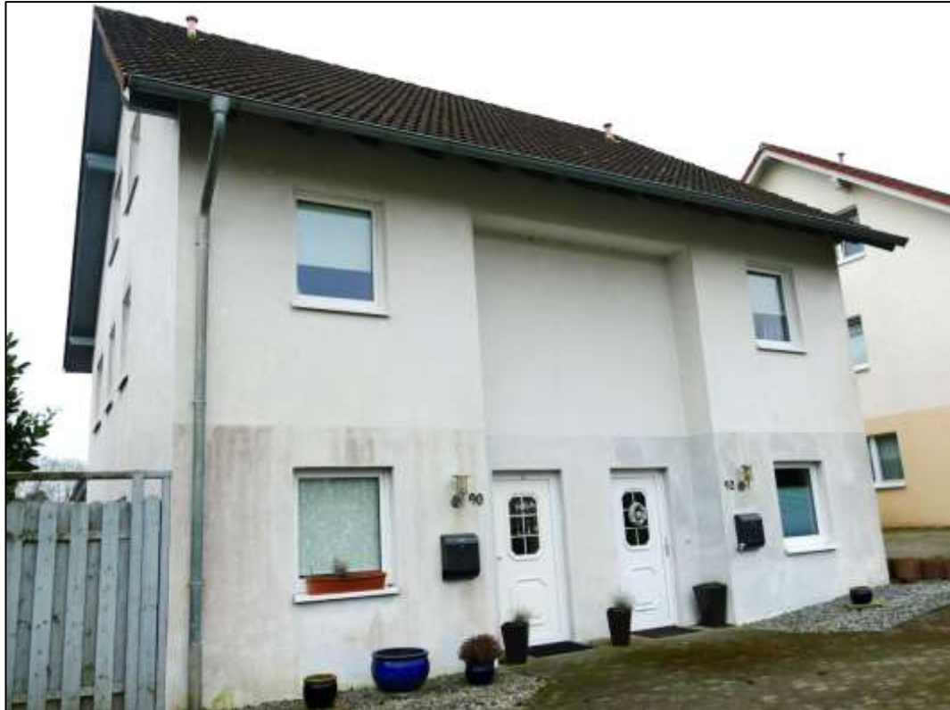
Haus Nr. 90 | 92: Nord-Ansicht
