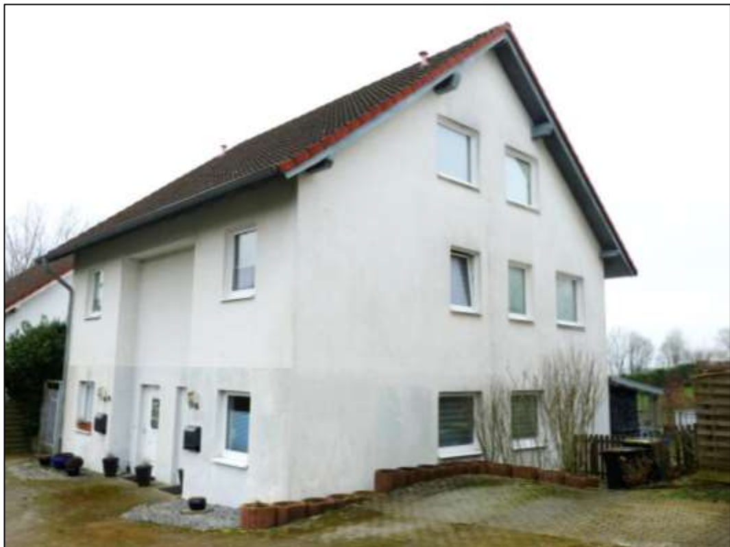
Haus Nr. 90 | 92: Nord-West-Ansicht
