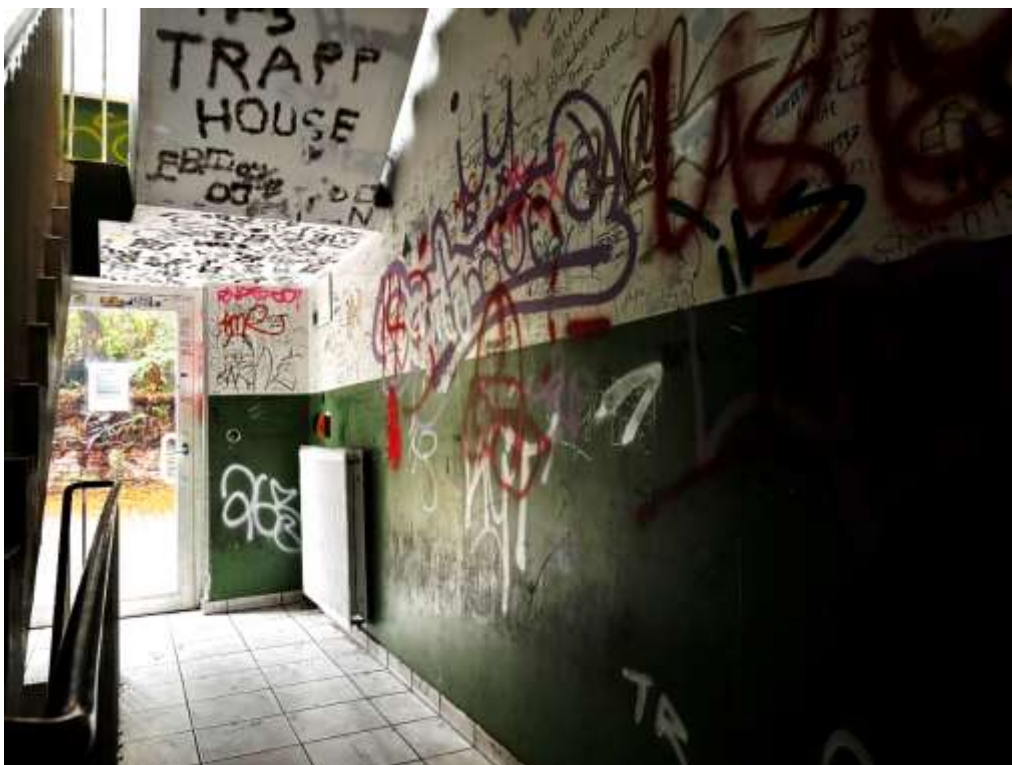
Treppenhaus, Ausgang Hofseite
