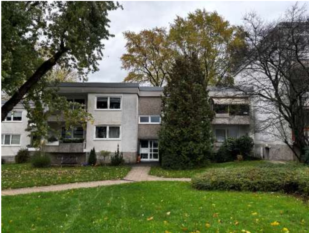
Ansicht Eingangsseite, Elchweg 6
