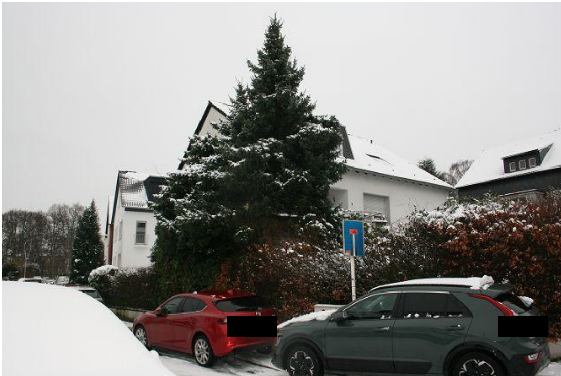
Bild 5 Das Gesamtobjekt an der Einmündung Defreggerstraße / „Halbe Höhe“.
