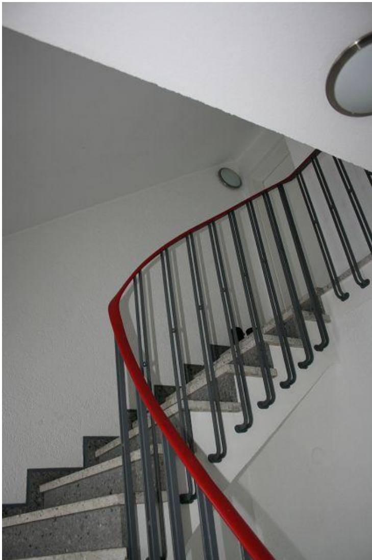
Bild 12 Detailaufnahme des Treppenhauses.
