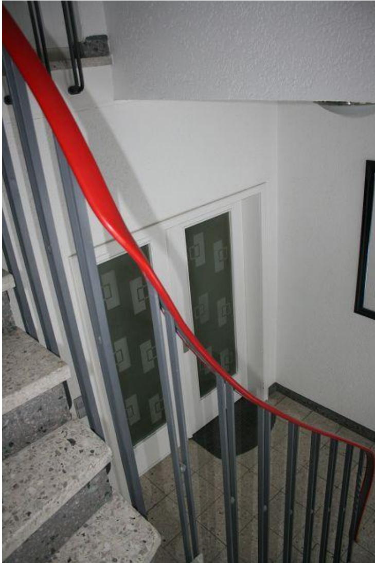
Bild 13 Treppenhaus mit Eingangstür zur mittleren Wohnung.
