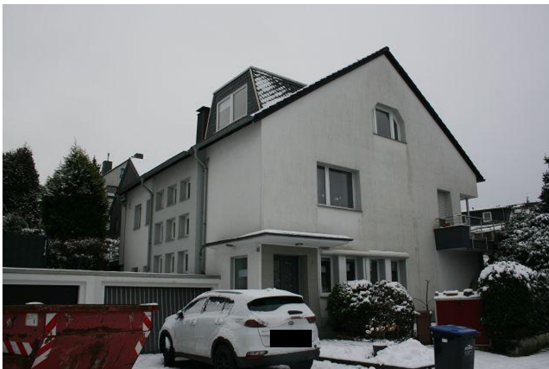
Bild 1 Das Gesamtobjekt zur Straße „Halbe Höhe“.
