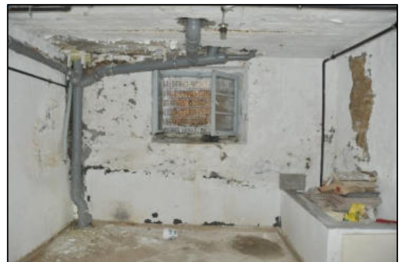
Abwasserleitungen
