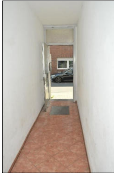
Treppenhaus Erdgeschoss, Blickrichtung Straße
