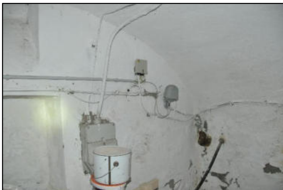
Hausanschluss Strom
