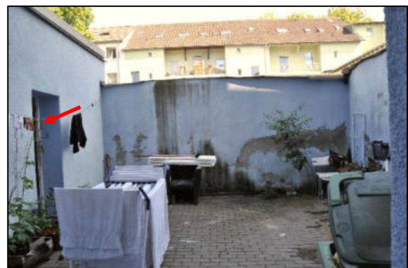
Innenhof, links Zugang Personalraum
