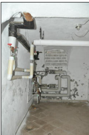
Hausanschluss Fernwärme
