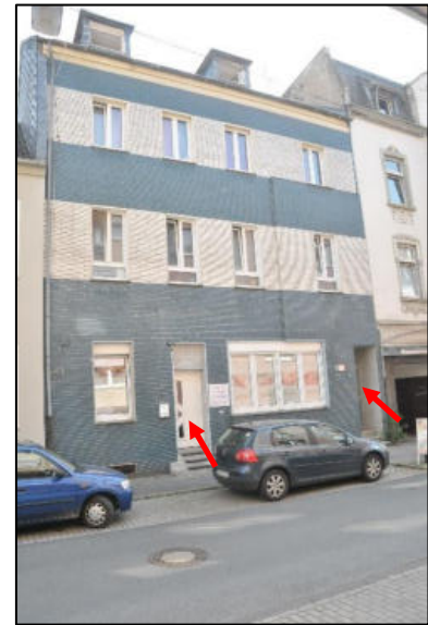
Straßenansicht, Mitte Eingang Praxis rechts Zugang Treppenhaus Wohnungen
