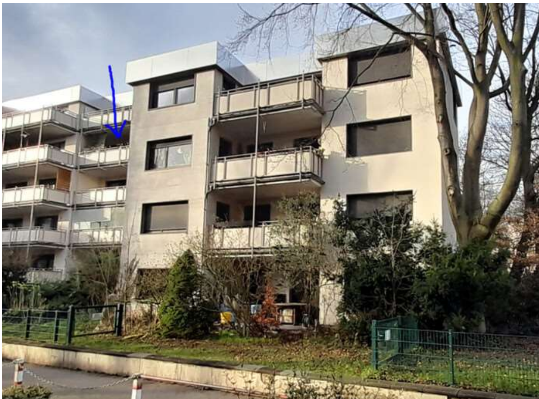
Bild 2 - Rückansicht mit Balkon
