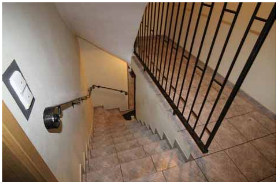
Sicht auf die Treppe vom Erdgeschoss zum Obergeschoss / OG
