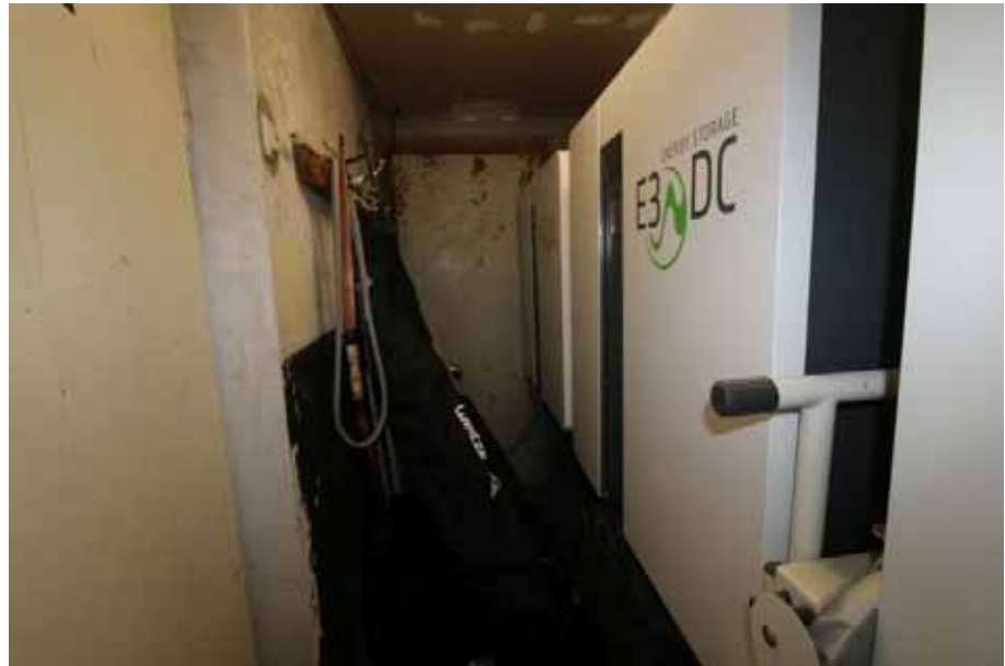
Sicht auf die Photovoltaiktechnik im Heizungsraum / EG
