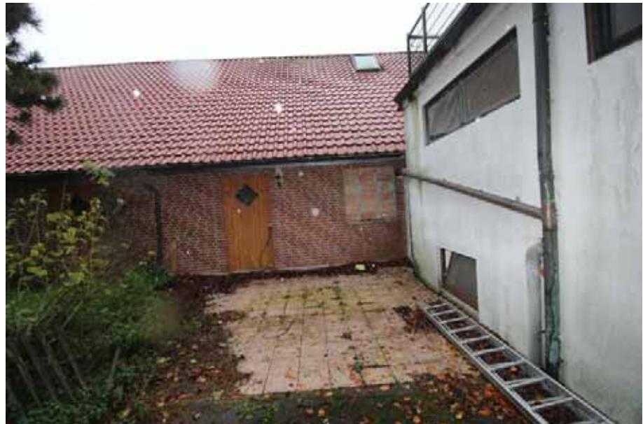
Sicht auf die Nordseite des Anbaus des Hauses Schorfheide 12 und auf die Südseite des Hauses Schorfheide 12a
