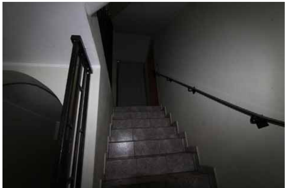
Sicht in das Treppenhaus / EG
