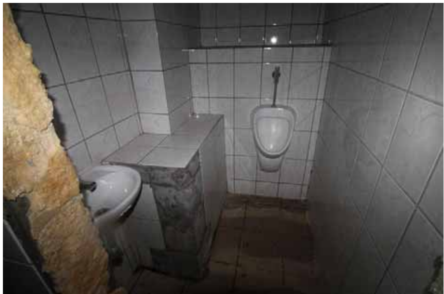
Sicht in den ehemaligen Sanitärbereich / KG
