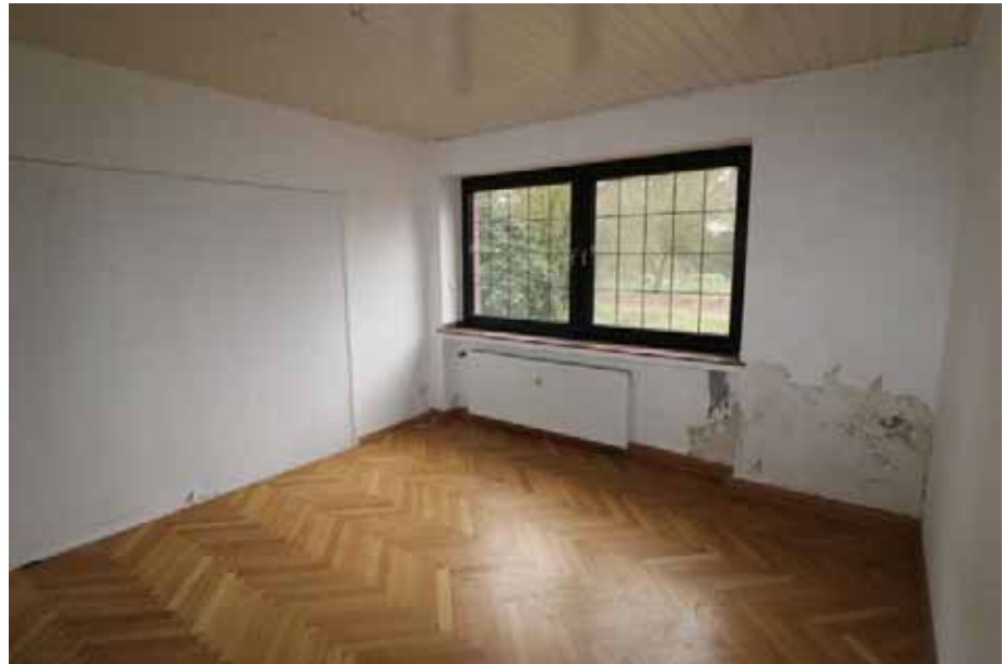
Sicht in den Raum 5 / EG
