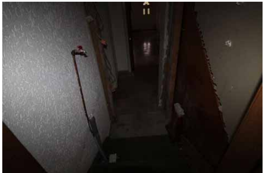
Sicht auf die Treppe zum tiefer liegenden Erdgeschossbereich / EG
