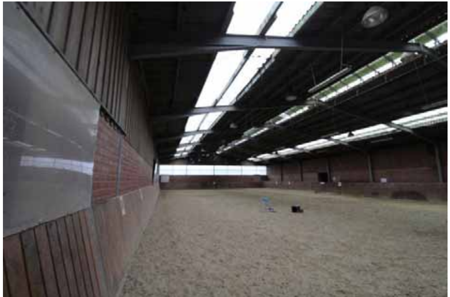
Sicht in die Reithalle
