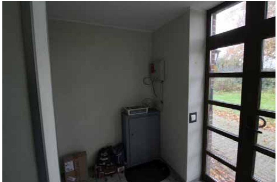
Sicht in den Treppenhausflur / EG
