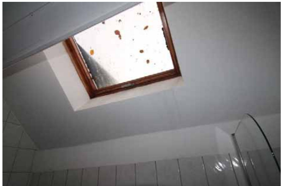
Sicht auf das Dachflächenfenster im Bad / OG
