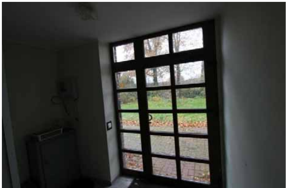
Sicht auf die Hauseingangstür / EG
