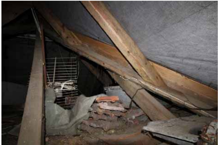
Sicht in den Spitzboden / DG
