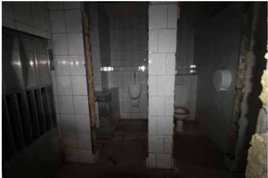
Sicht in den ehemaligen Sanitärbereich / KG
