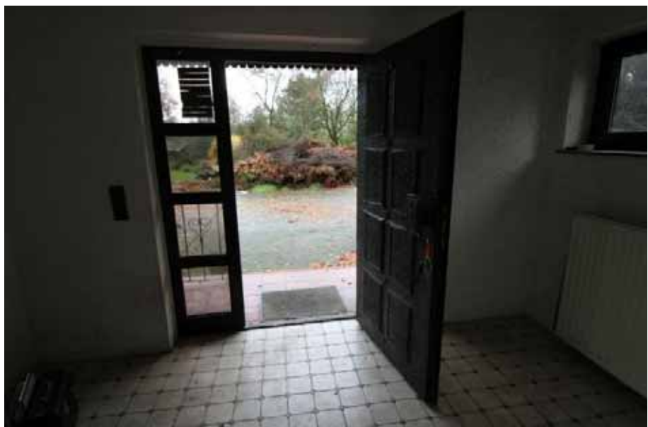
Sicht auf den Hausein- gangsbereich an der Nordseite des Wohn- hauses Schorfheide 12a
