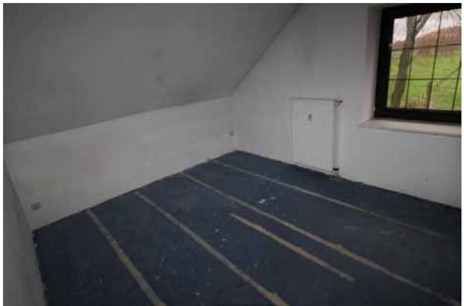
Sicht in den Raum 1 / DG
