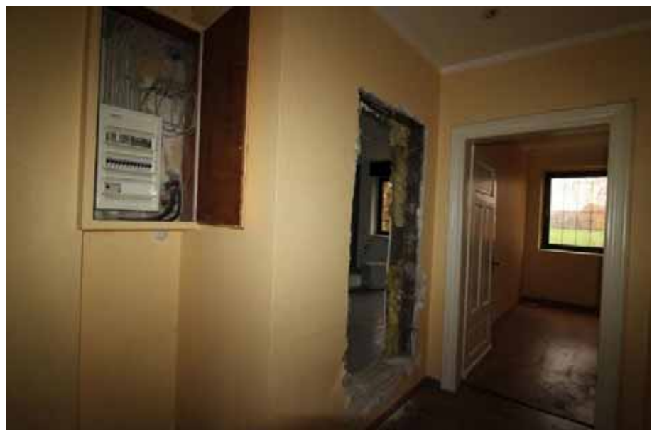
Sicht in den Flur / OG
