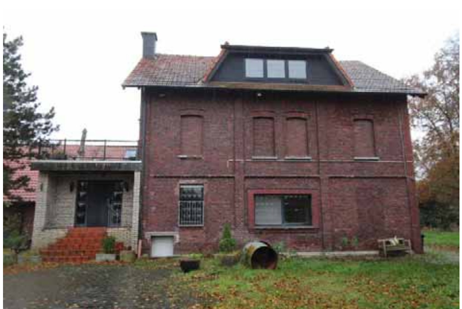
Sicht auf die Nordseite des Hauses Schorf- heide 12a
