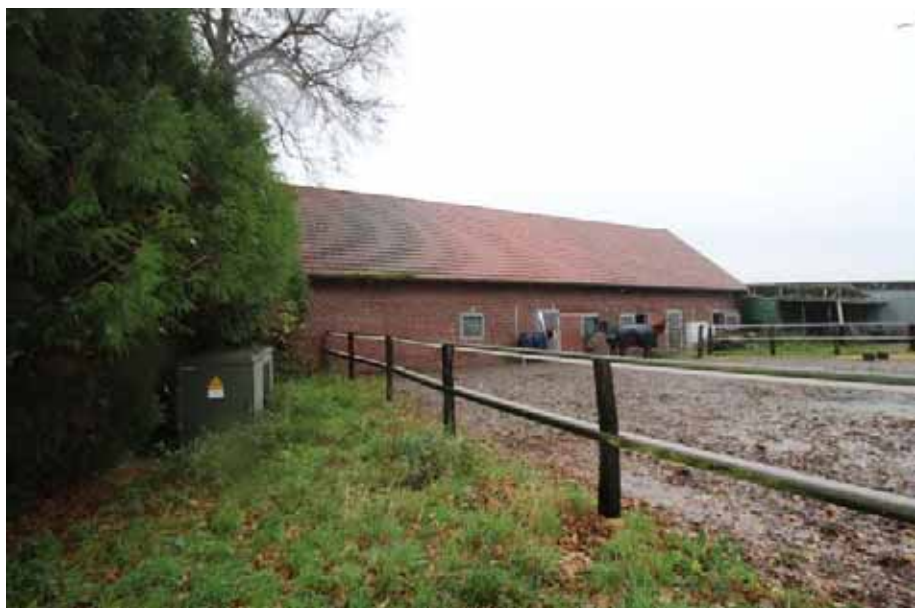
Sicht auf die 10kv-Station (Flurstück 32)
