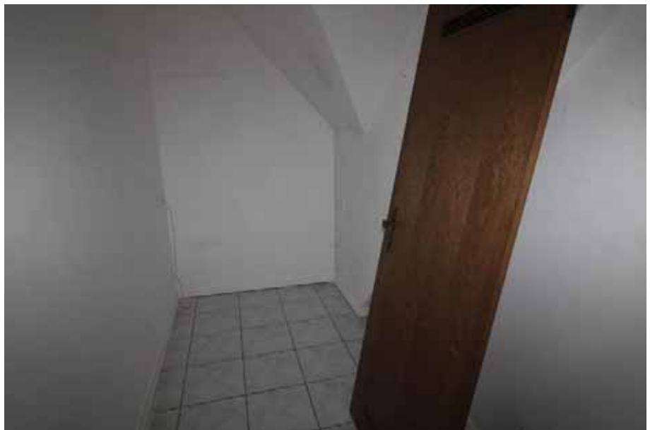
Sicht in den Abstell- raum / DG
