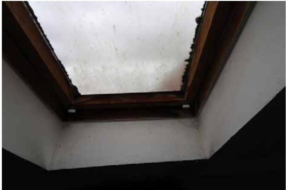
Sicht auf das Dachflächenfenster im Bad / DG
