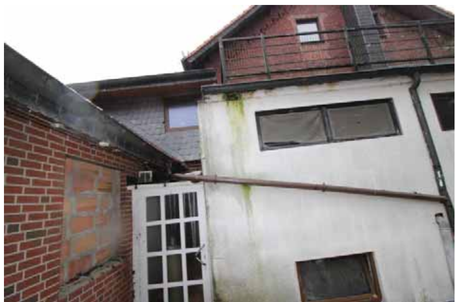
Sicht auf den Eingangsbereich an der Südseite des Hauses Schorfheide 12a
