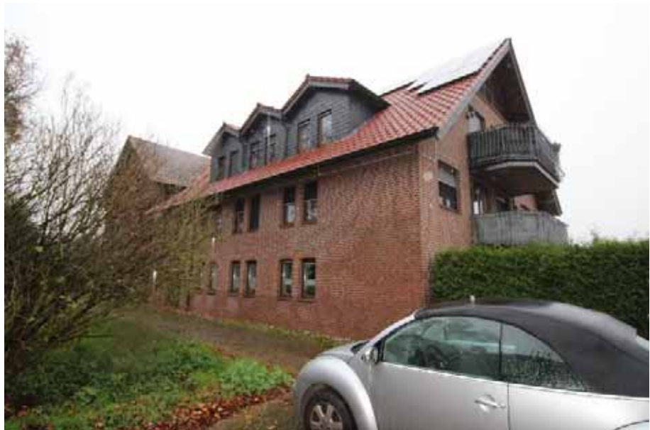
Sicht auf die Süd-Westansicht des Hauses Schorfheide 12
