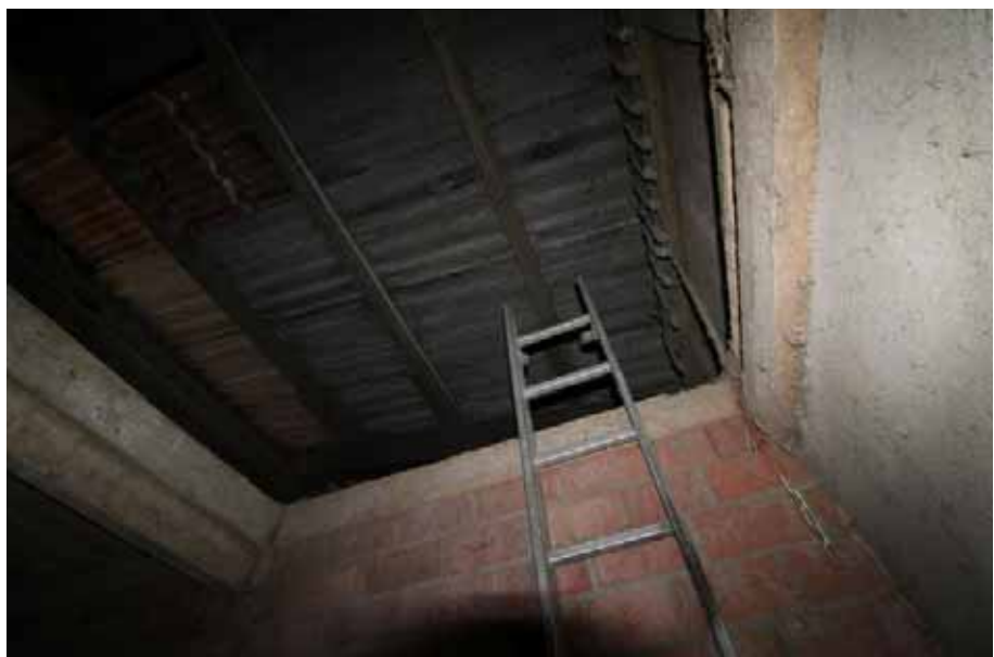
Sicht auf den Zugang zum Strohlager
