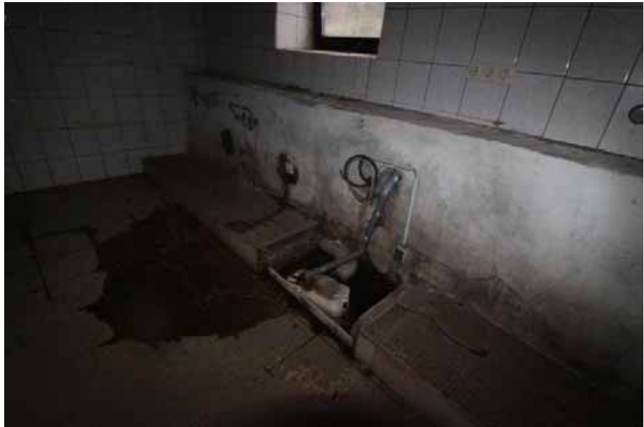
Sicht in den ehemaligen Sanitärbereich / KG
