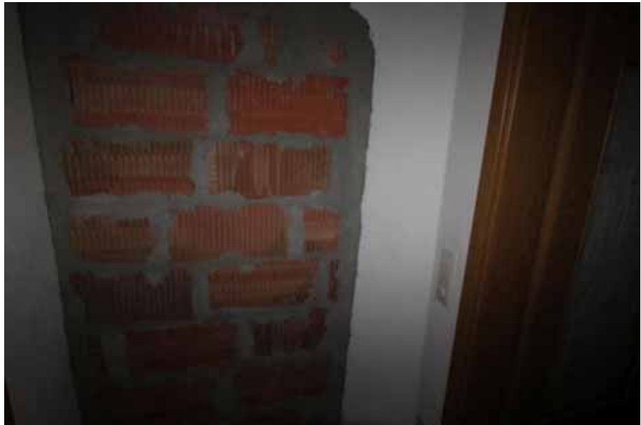
Sicht auf den zugemauerten Zugang zum Teilbereich 1 der Wohnung 1 / OG
