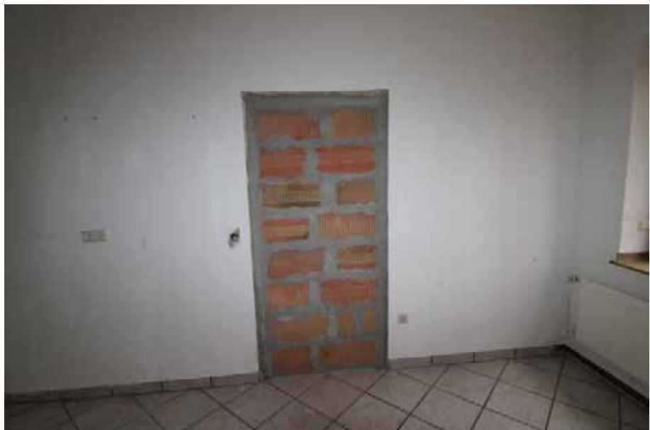
Sicht auf den zugemauerten Zugang zum raum 3 / EG
