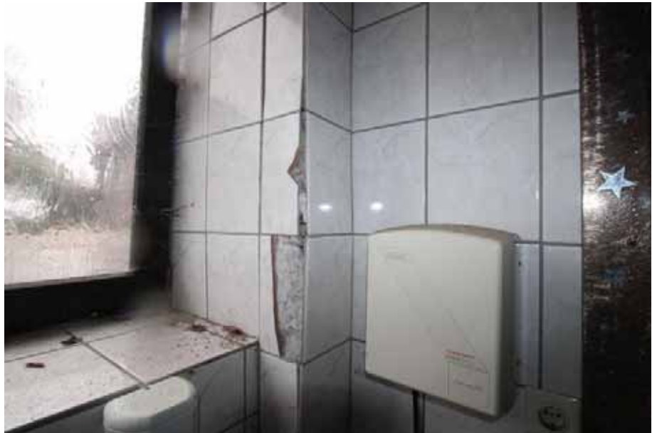
Sicht in den ehemaligen Sanitärbereich / KG
