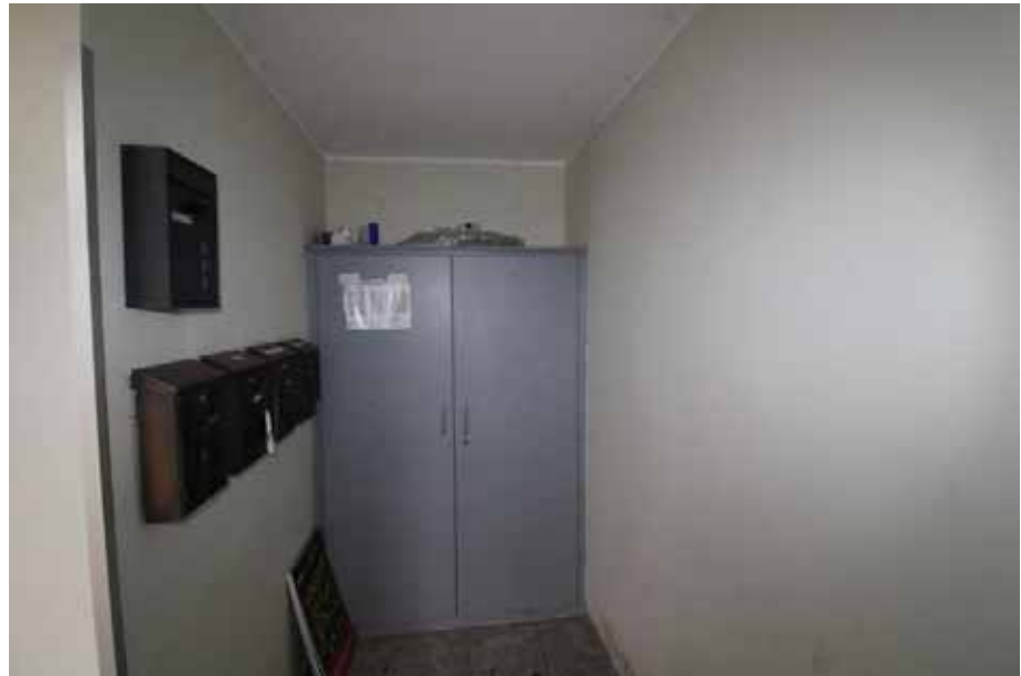
Sicht auf die Briefkastenanlage im Treppenhauseflur / EG
