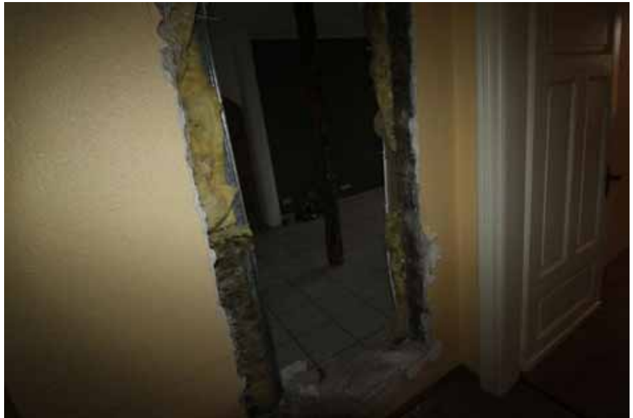
Sicht auf den Durchbruch vom Flur zum Raum 1 / OG
