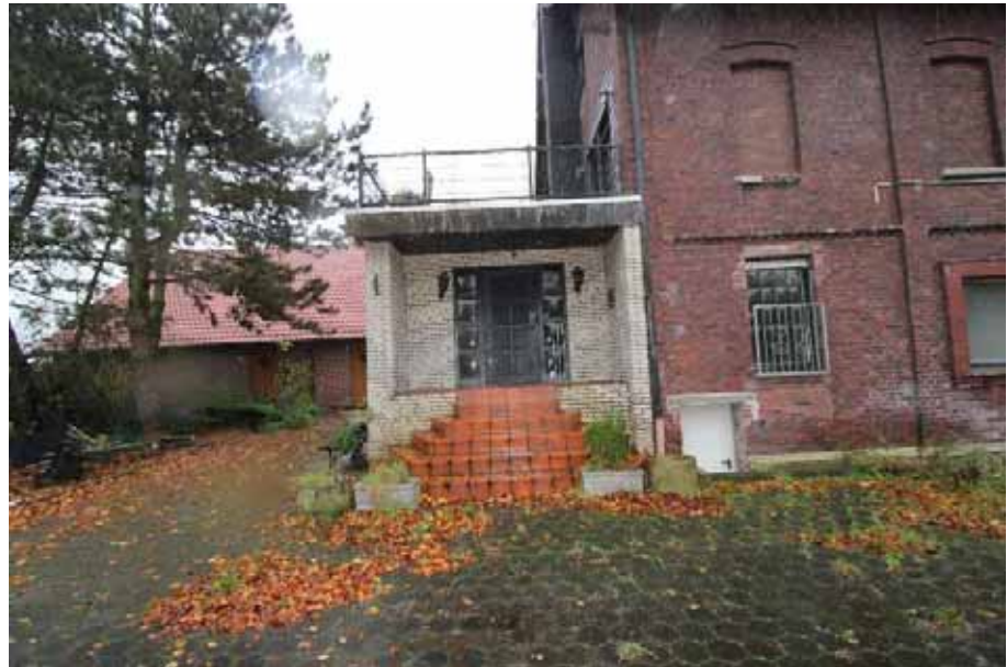
Sicht auf den Hauseingangsbereich an der Nordseite des Hauses Schorfheide 12a
