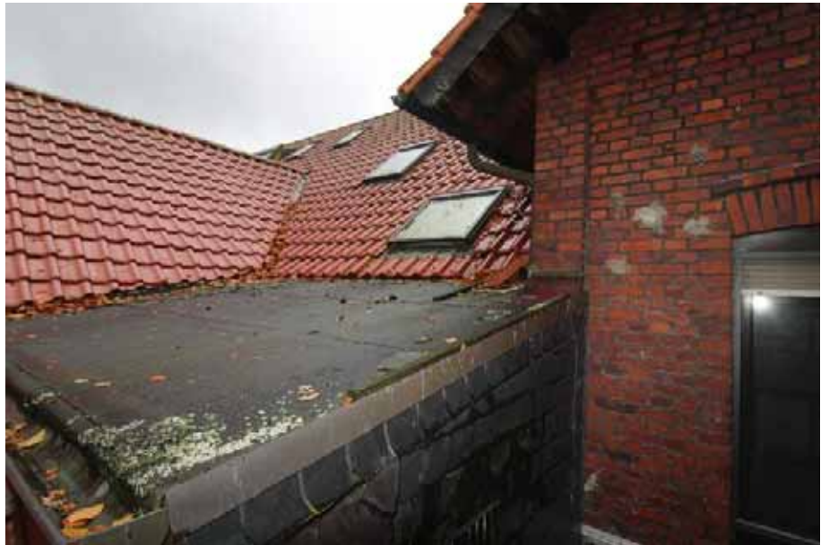
Sicht auf die Dachflächen der Häuser Schorfheide 12 und 12a
