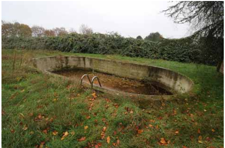
Sicht auf ein ehemali- ges Schwimmbecken
