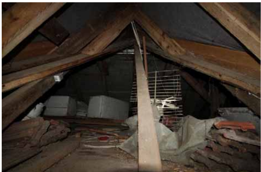
Sicht in den Spitzboden / DG
