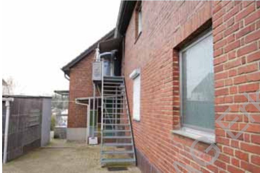
Hofansicht Blickrichtung Norden / Straße (Garage LP Nr. 2, Vorderhaus LP Nr. 1, Hinterhaus LP Nr.2)
