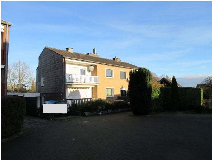
Wendehammer und Doppelhaus Ardennenstr. 16 - 18
