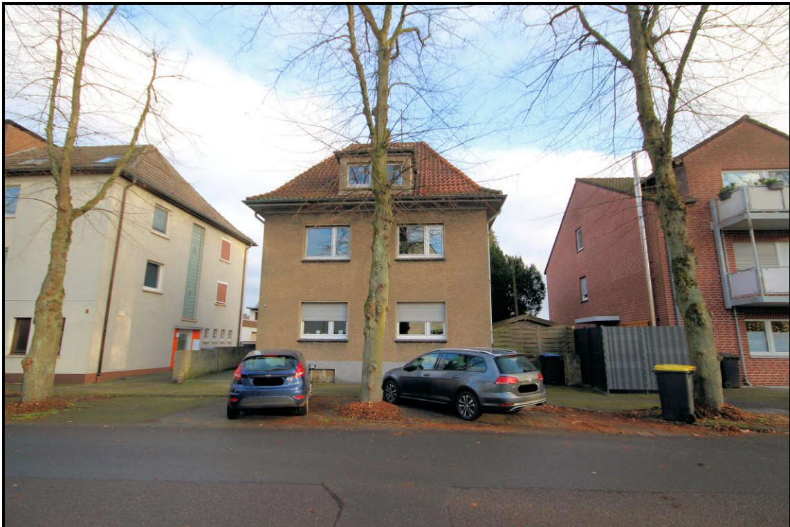
Bild 4: Ansicht von Südwesten
