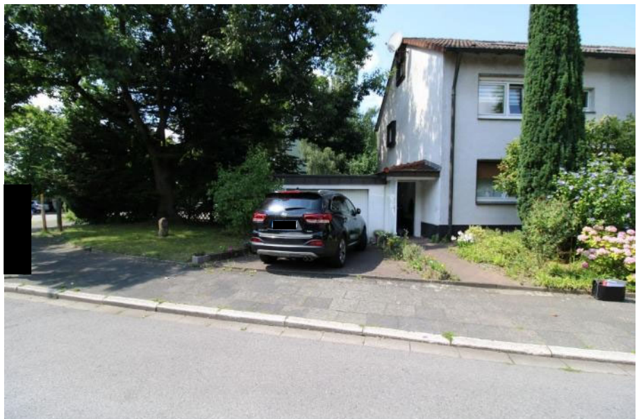
Sicht von der Straße aus auf die Vorder- und Giebelfassade des Wohnhauses
