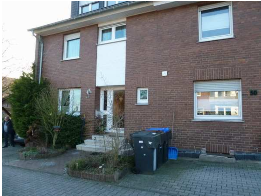
Grundstücksansicht aus Nordosten
