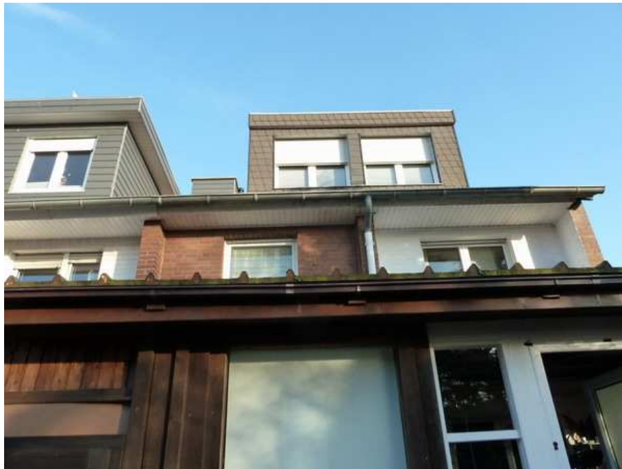
Grundstücksansicht aus Westen
