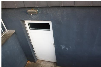
rechts Kelleraußentreppe / Kellereingang
