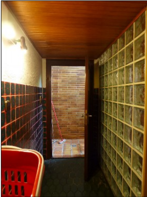
Teilansicht Kellerflur mit Kellerausgang
