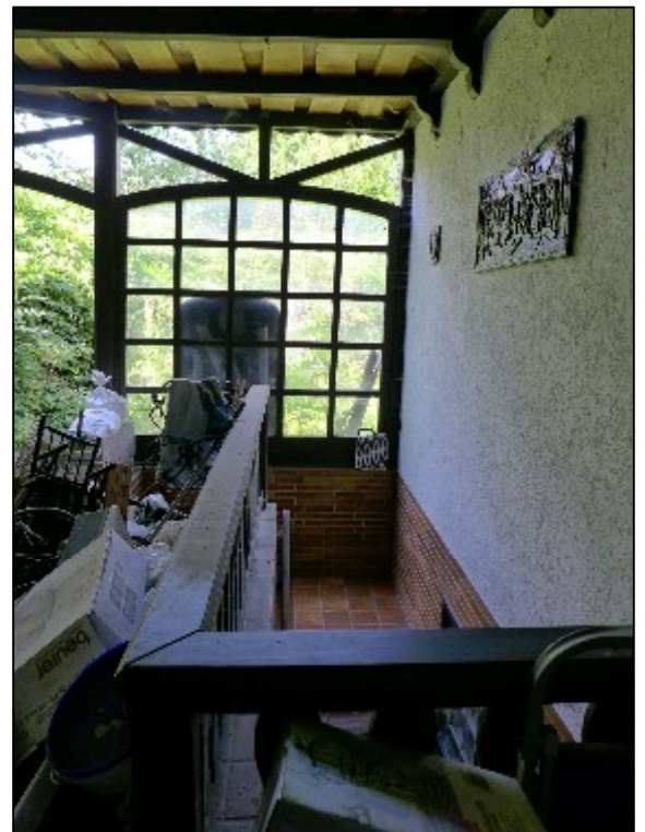
Teilansicht überdachter Freisitz mit Abgang zum Keller
