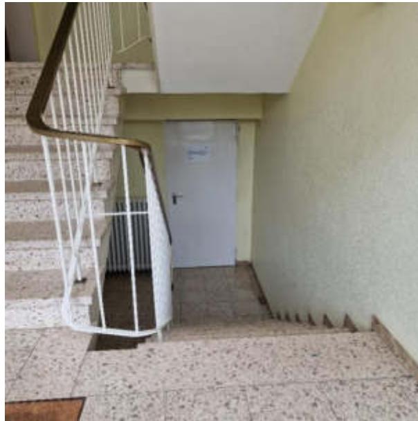
Kellertreppe Hochfelder Str. 78
