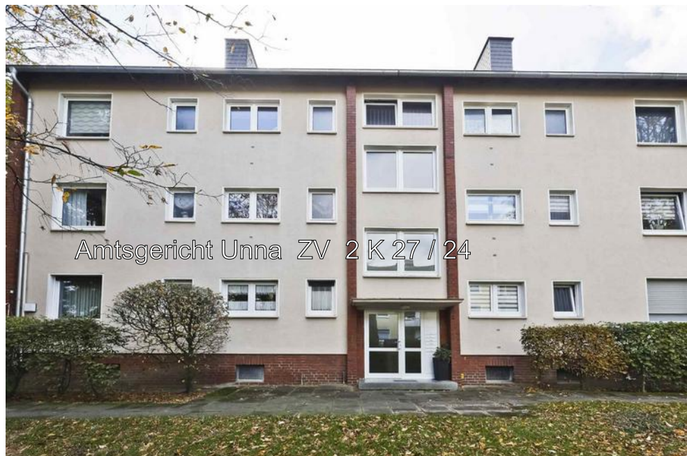
Foto Nr. 2 Ansicht von Osten - Hauseingang
