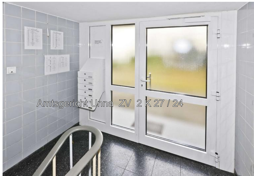
Foto Nr. 2 EG: Hauseingang (Gemeinschaftseigentum)
