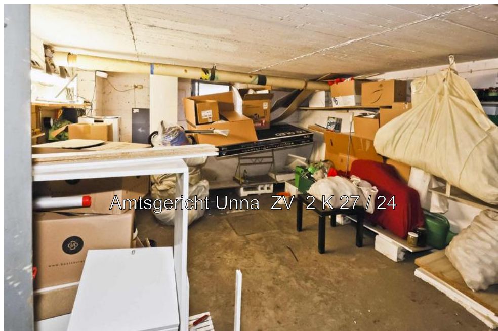
Foto Nr. 2 KG: Kellerraum zur WE Nr. 3
