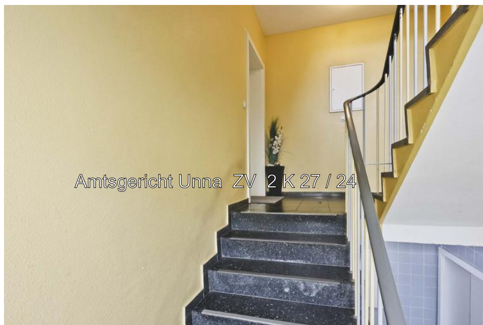
Foto Nr. 2 Treppenhaus (Gemeinschaftseigentum)
