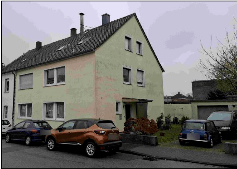
Foto 1: Ansicht von der Straße
