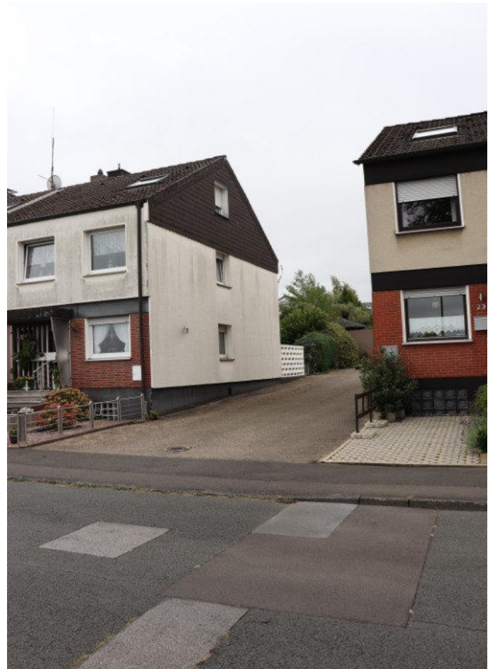
Bild 6 Rückansicht Edelweißstraße 21 (von der Garagenhofzufahrt aus gesehen) -Obergeschoss und Dachgeschoss-
