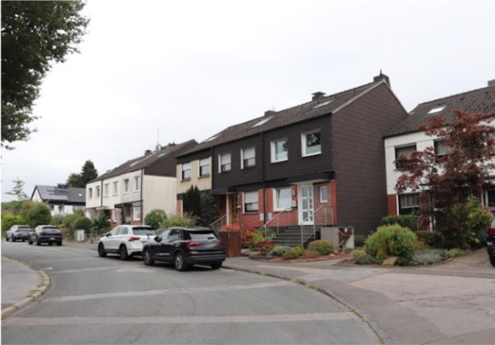
Bild 1 Straßensituation Edelweißstraße -Blick in Richtung Südosten-
