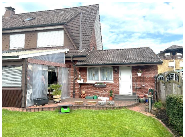
Bild 4 Rückwärtige Ansicht mit Anbau
