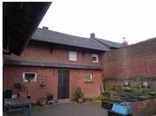
Wohnhauseingang vom Innenhof
