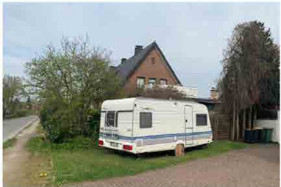
Straßenseite, Ansicht des Objekts von Osten
