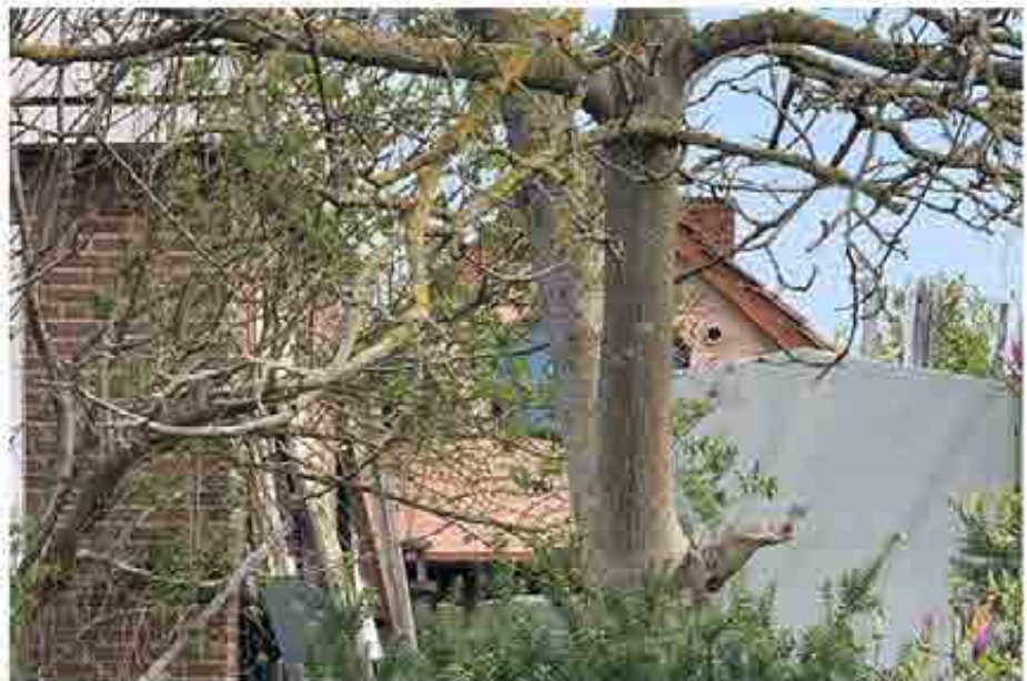
Garage, Ansicht von Südosten
