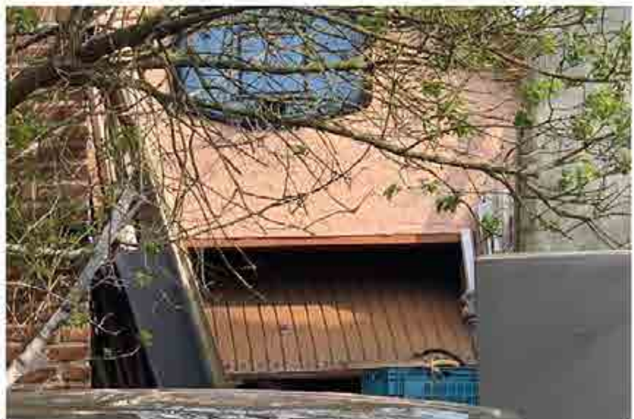
Garage, Ansicht von Südosten
