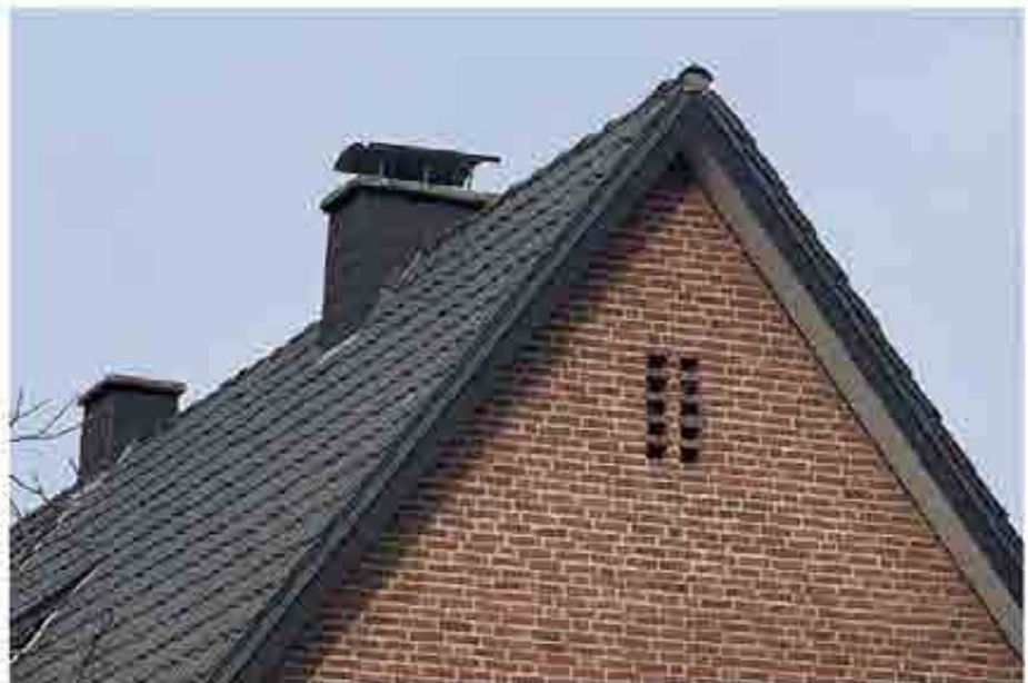
Detail Dach, Ansicht von Osten
