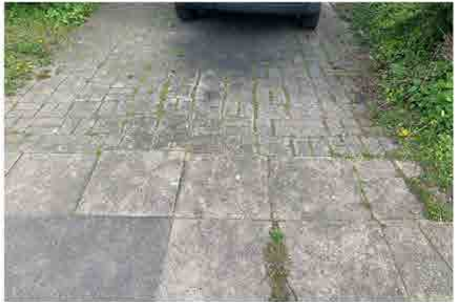
Straßenseite, Zufahrt Garage, Detail Bodenbelag
