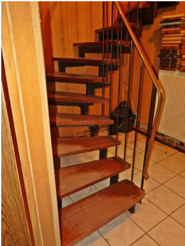
Treppe zum Kellergeschoss
