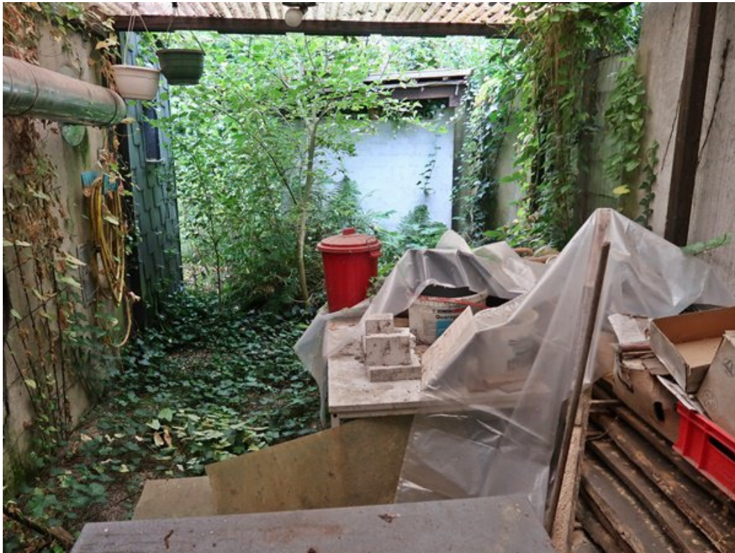
Unterstand als rückseitiger Anbau an die Garage
