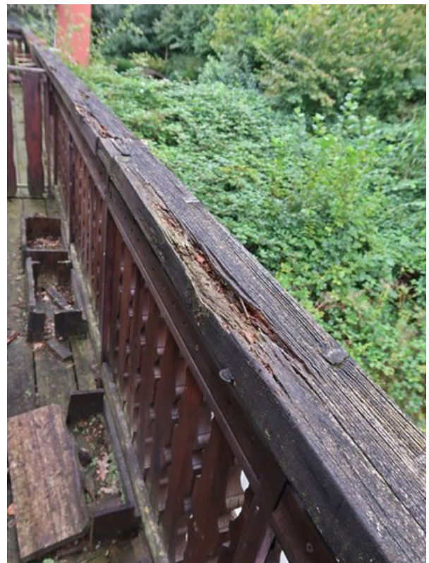
Verwitterungsschäden Balkonbrüstung
