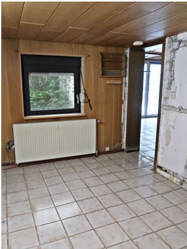
Kellerraum unter der Garage
