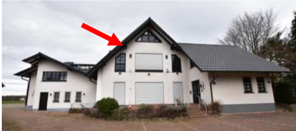
(Rückseite des Gebäudes)
