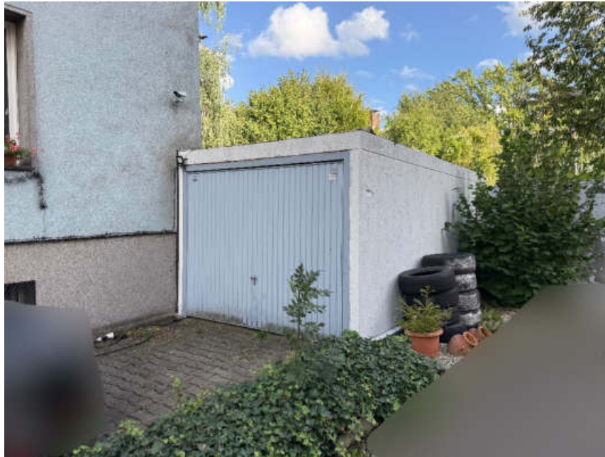
Bild 3: Garage am Hauptgebäude
