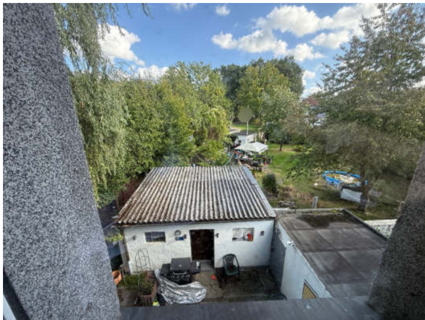
Bild 18: Ansicht des Nebengebäudes
