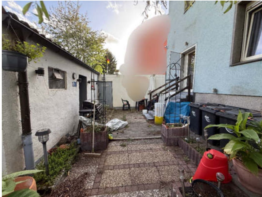
Bild 17: Zuwegung zum Nebengebäude und zur Garage, Außentreppe
