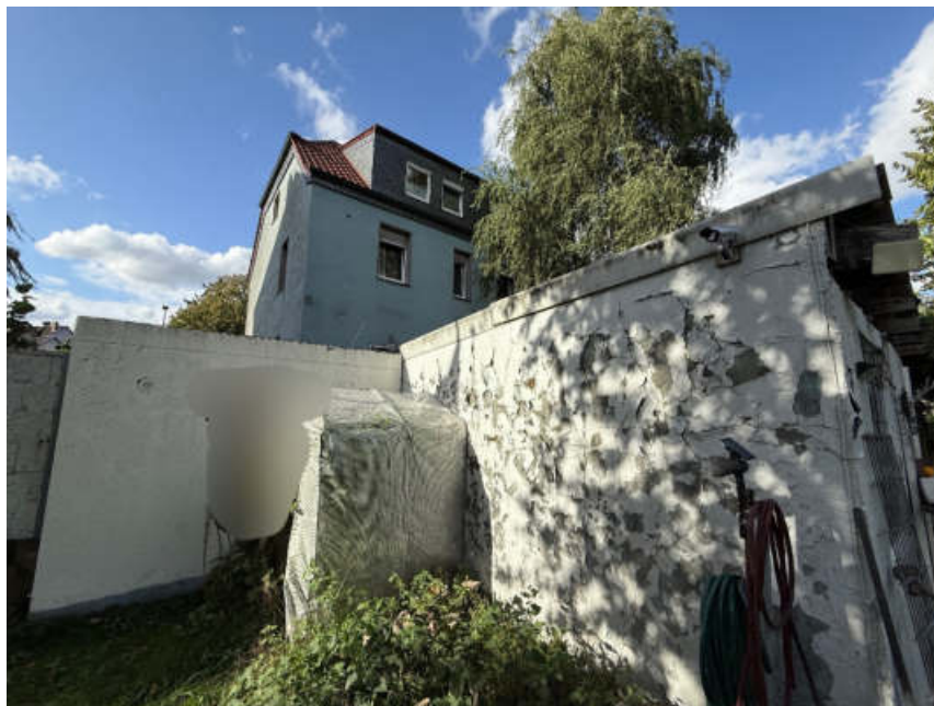
Bild 10: Rückansicht des Hauptgebäudes, der Garage sowie des Nebengebäudes
