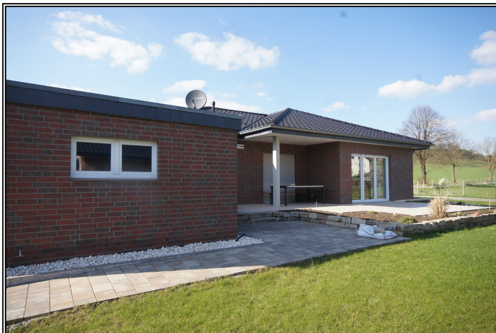
Rückwärtige Ansicht von Süden
